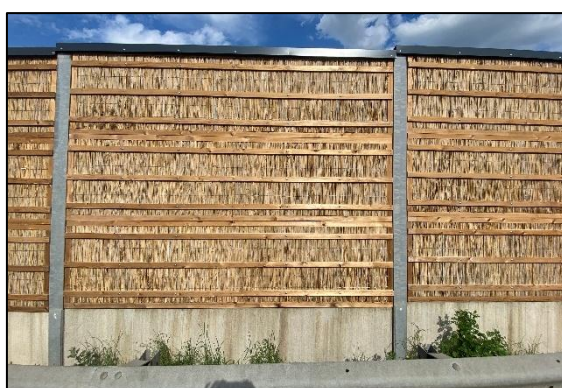
Abbildung 11: untersuchte Schilf-LSW an den Schnellstraße S33.
