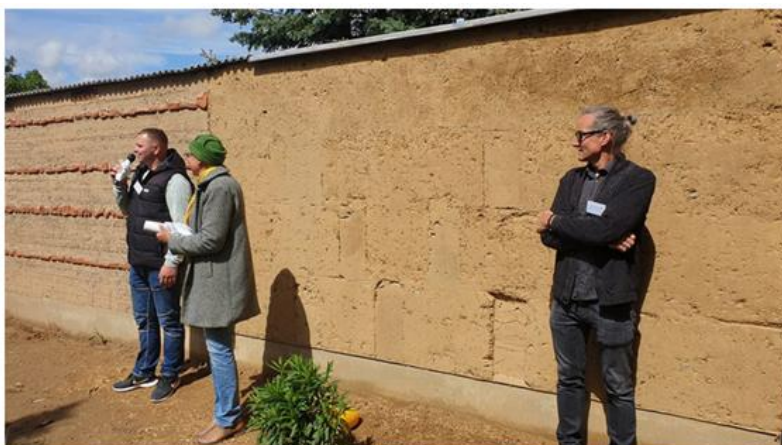
Abbildung 25: Lehmwand (Quelle: https://zentrum-fuer-peripherie.org/startseite-test/projekte/brandenburgs-alhambra/probewand , zuletzt abgerufen am 03.12.2025).
