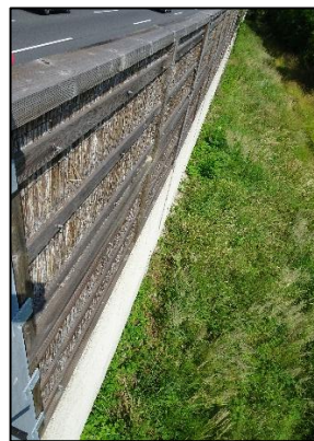
Abbildung 18: Vorderseite der an der Autobahn A22 untersuchten Schilf-Holzbeton-LSW bei Messungen der Luftschalldämmung (links) sowie Rückseite der LSW (rechts).
