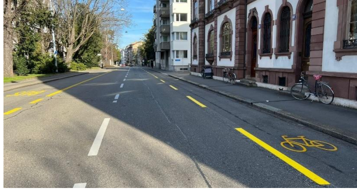
Abbildung 4 Velostreifen in Basel (Foto: Basel-unterwegs.ch)
