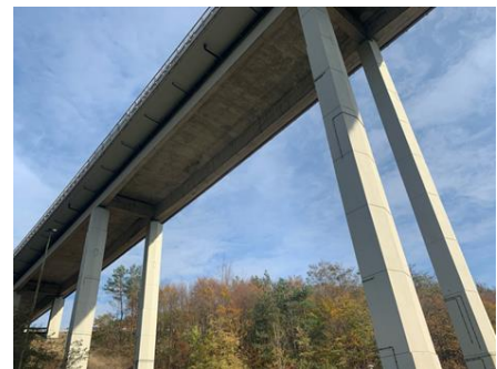
ABB 1. Plattenbalkenbrücke, Baujahr 1976
