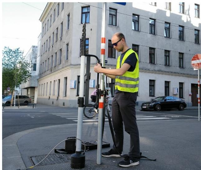
**Abbildung 51: Montage einer MioVision Scout Kamera** (Quelle: con.sens verkehrsplanung).
