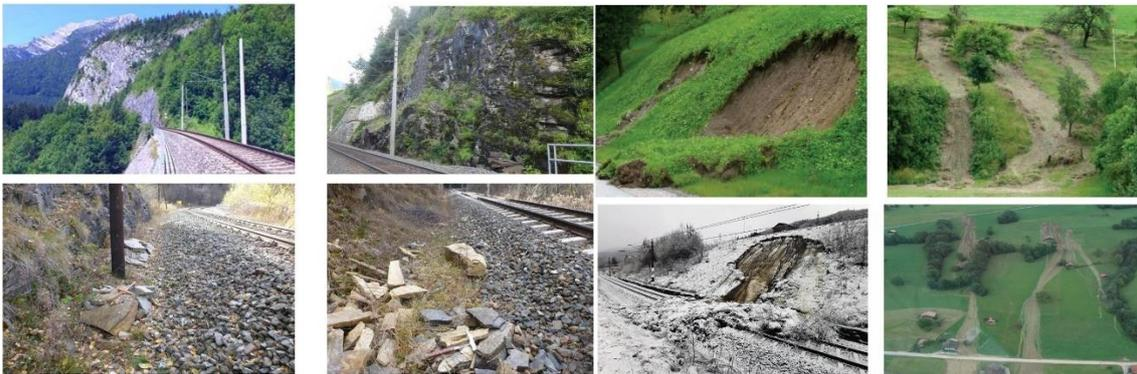
**Abbildung 13: Beispiele für die Auswirkungen der gravitativen Naturgefahren Steinschlag und seichtgründige Rutschung bzw. Hangmure auf die Schieneninfrastruktur.**
