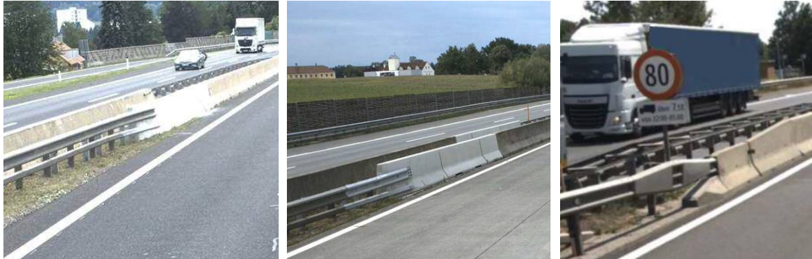
Abbildung 4: Situationen realer Einbaubedingungen (Quelle: ASFINAG, VAKF)
