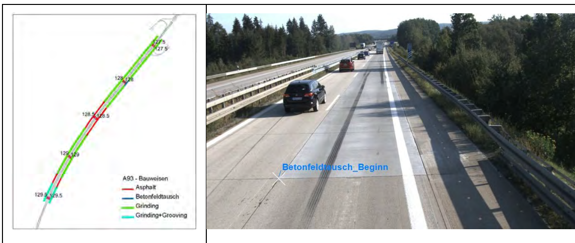
Abbildung 19: Abfolge der Belagsabschnitte und Betonfeldtausch auf der A93 Luhe-Wildenau.
