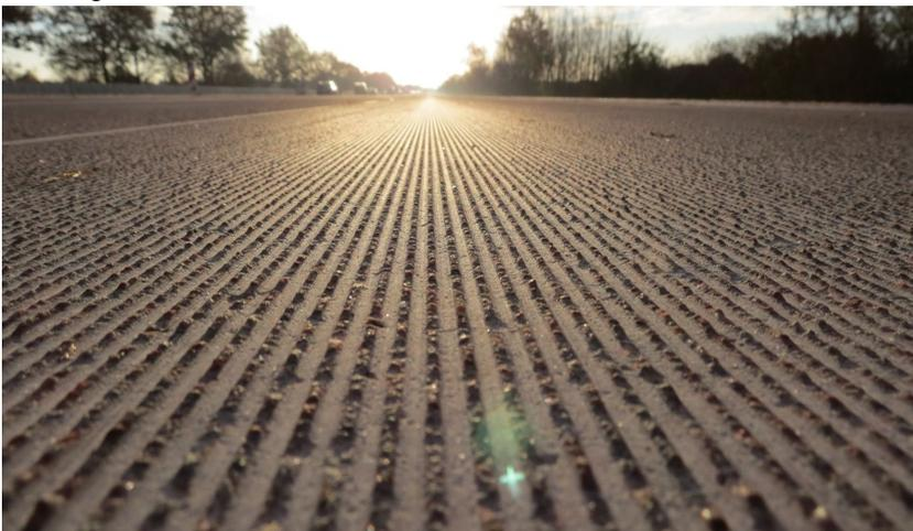
ABB 1. Texturgrinding auf Beton.
