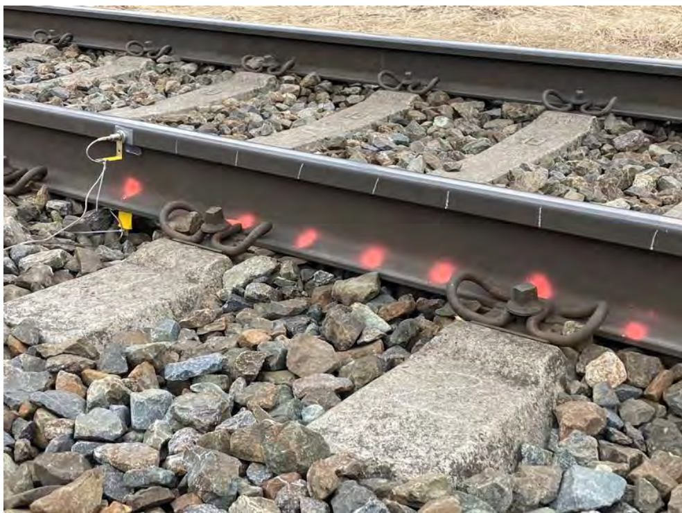
Abbildung 84: Betonschwellen auf Schotteroberbau (Freie Strecke).
