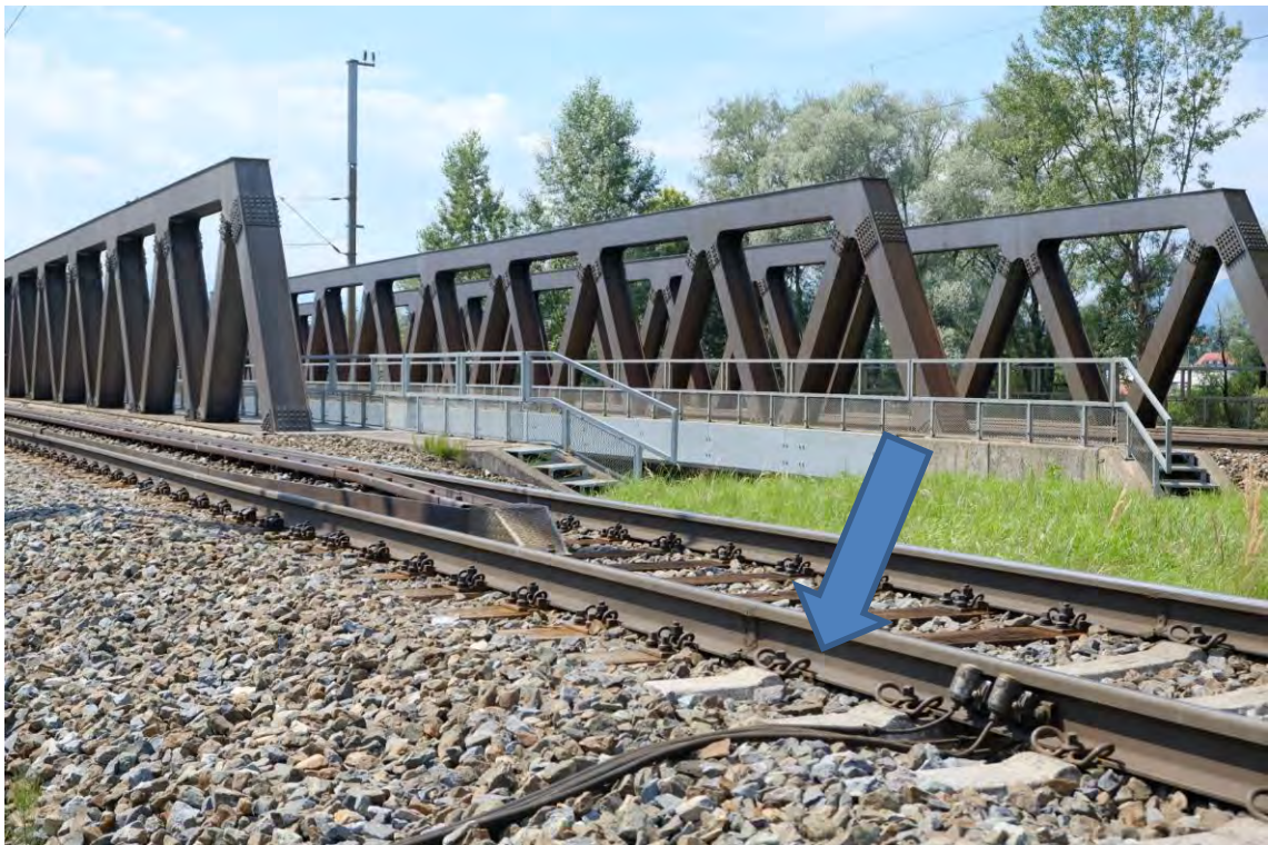
Abbildung 85: Übergang von Schienen- und Schwellentyp kurz nach der Brücke Richtung Osten.
