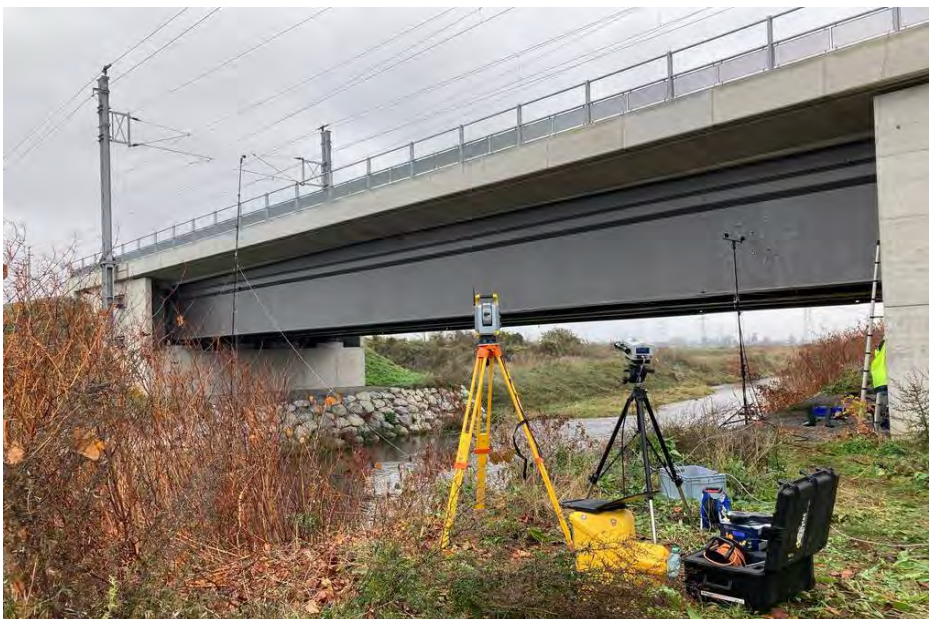
Abbildung 1: Brücke über die Schwechat (Ansicht von Südwesten).
