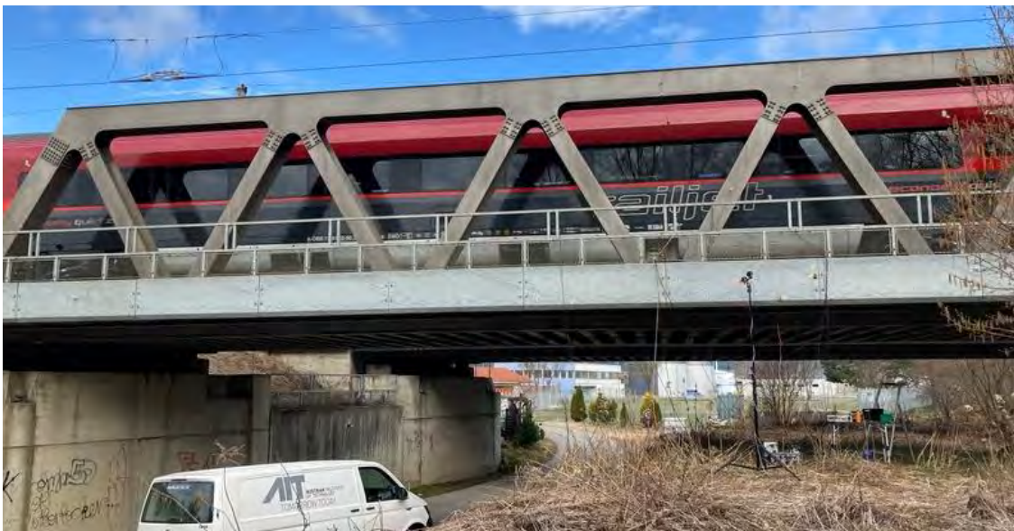
Abbildung 14: Brücke (oben) sowie Nahaufnahme von Zugüberfahrt (unten) (Ansicht von Süden).
