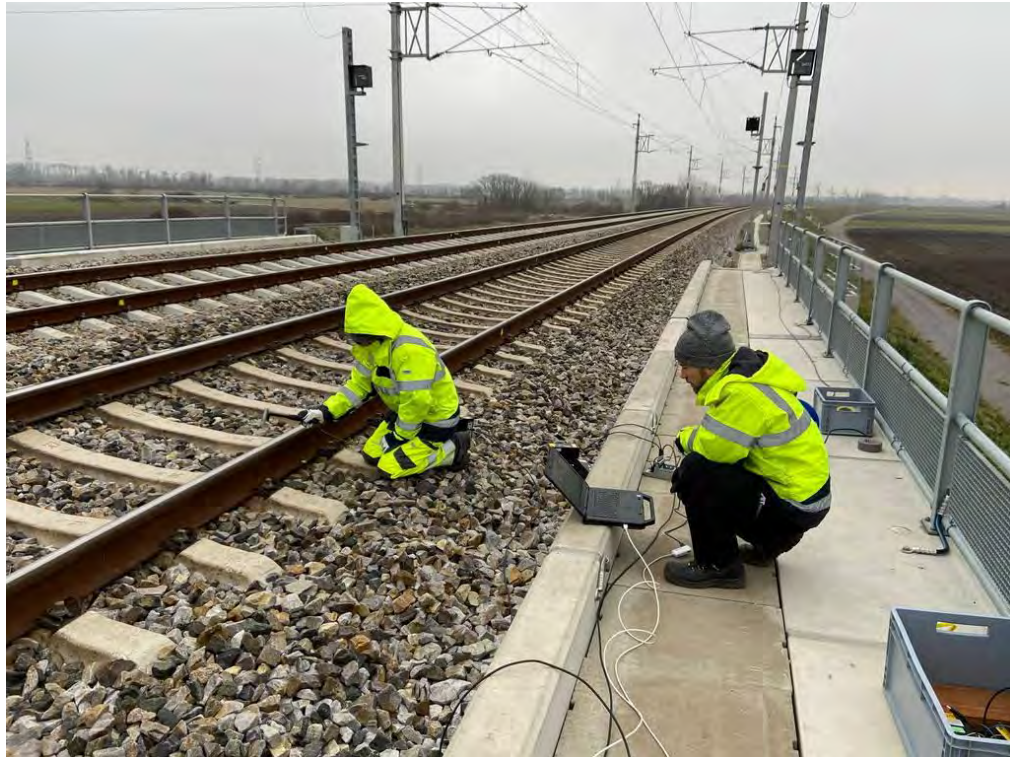
Abbildung 73: Messung mit Impulshammer auf der Brücke.
