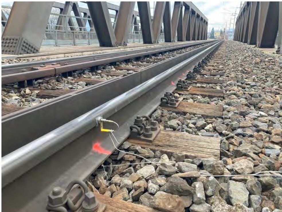
Abbildung 83: Holzschwellen auf Schotteroberbau (Brücke).
