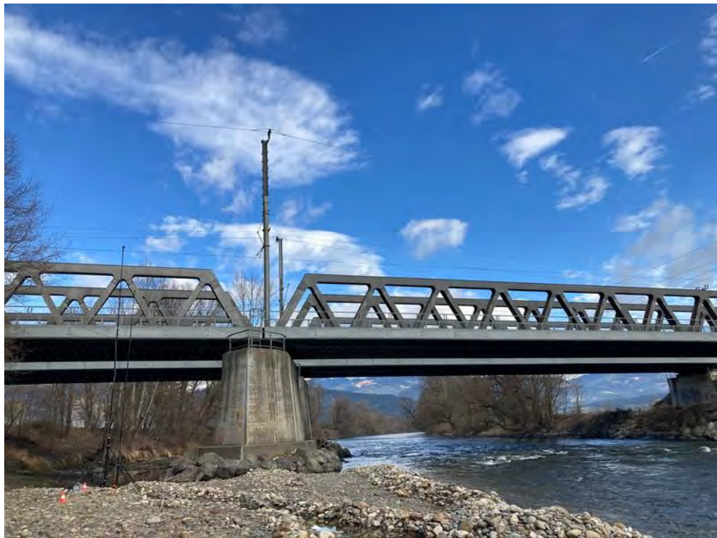
Abbildung 81: Brücke über die Mur (Ansicht von Süden).
