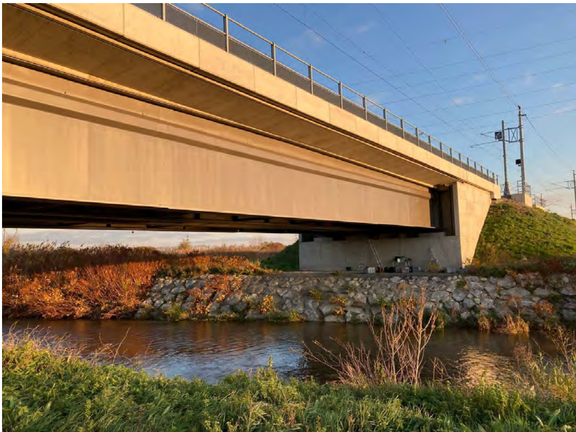
Abbildung 67: Brücke über die Schwechat (Ansicht von Nordwesten).
