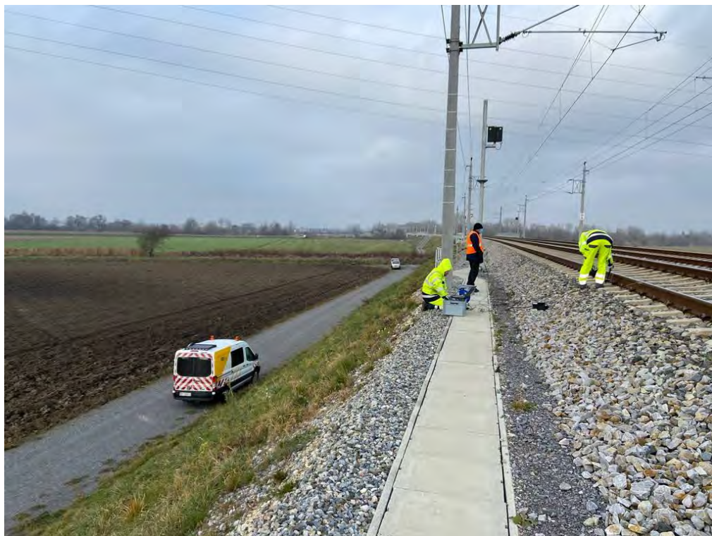
Abbildung 74: Messung mit Impulshammer auf der freien Strecke am Damm.
