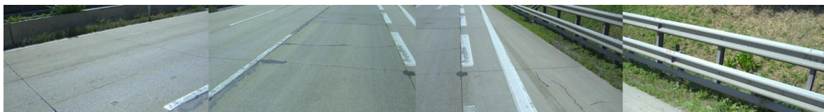
Abbildung 12: Beispiel Aufnahme Straße
