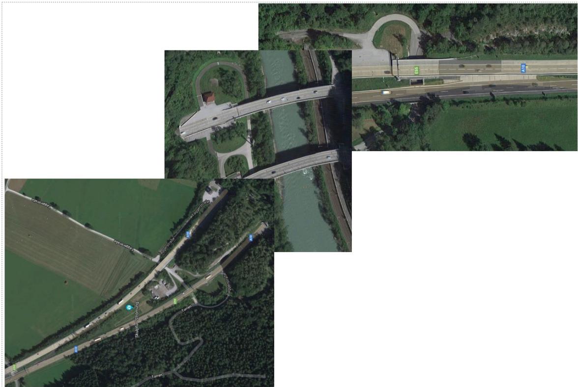
Abbildung 15 Bereich der A10 Tunnelbaustelle: Ofenauer Tunnel (links unten) bis Hiefler Tunnel (rechts oben)
