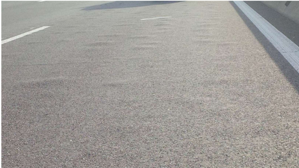
Abbildung 6: Blasenbildung – Foto ASFINAG [24]
