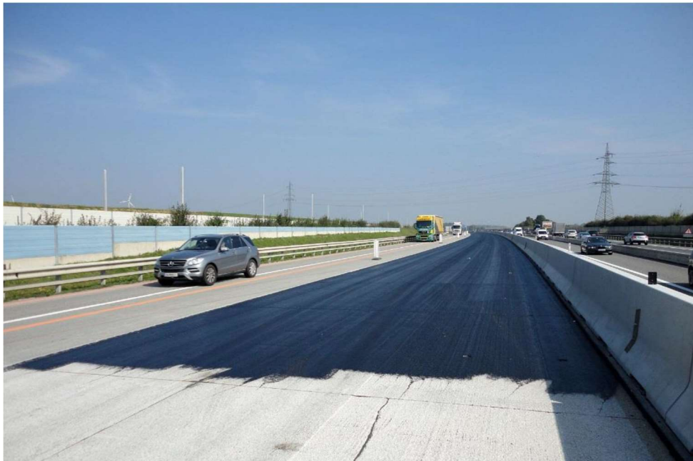
Abbildung 1: Vorgespritzte Betondecke, Foto Zehetner [22]
