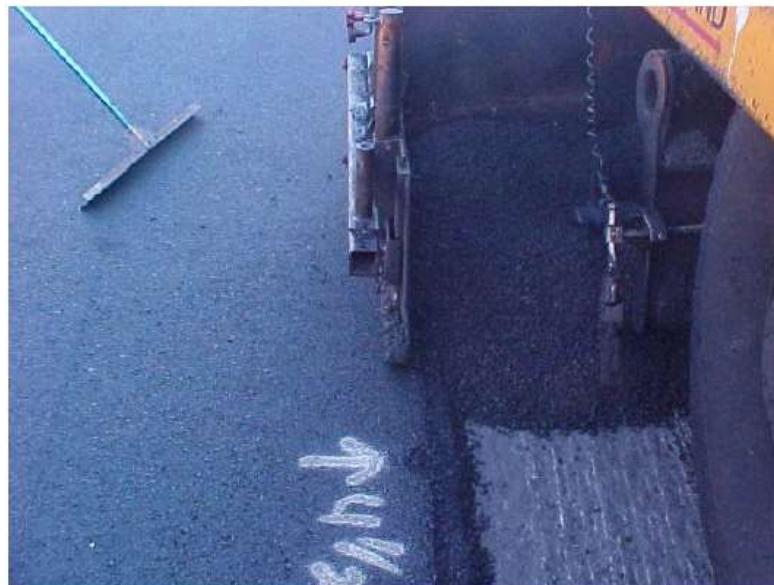
Abbildung 9: Hinweise zum Einbau (Überlappung) nach [34]
