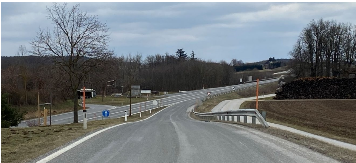
Abb. 4-12: Auffahrt Gföhl 2: Blick von der Rampenfahrbahn in Richtung Beschleunigungstreifen bzw. Hauptfahrbahn
