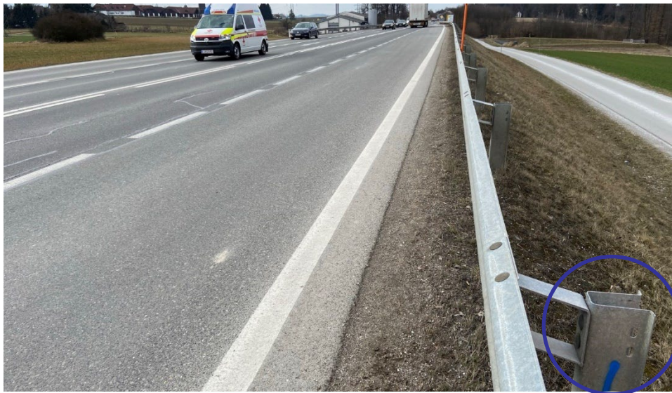
Abb. 4-9: Mitte des Beschleunigungstreifens in Gföhl 1: Kennzeichnung und Blick vom möglichen Installationspunkt des Masts an der Leitschiene
