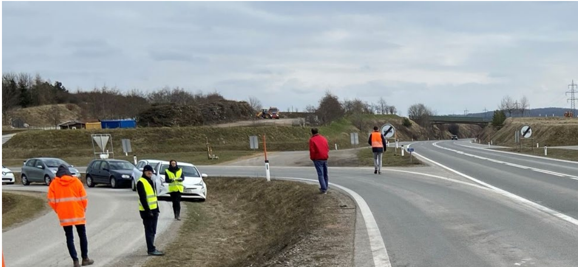
Abb. 4-6: Blick auf die Auffahrt Gföhl 1: Ende der Rampenfahrbahn (links), aus dem Einschnittsbereich mit Brücke kommende Hauptfahrbahn (rechts)
