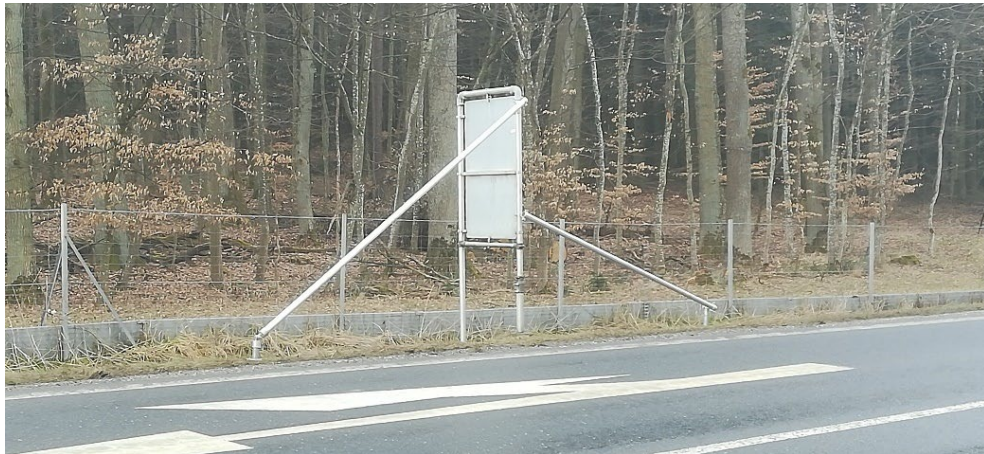
Abb. 5-5: Beispiel einer Vorbereitung mit einer Abspannung eines Verkehrszeichens bei Maissau 2
