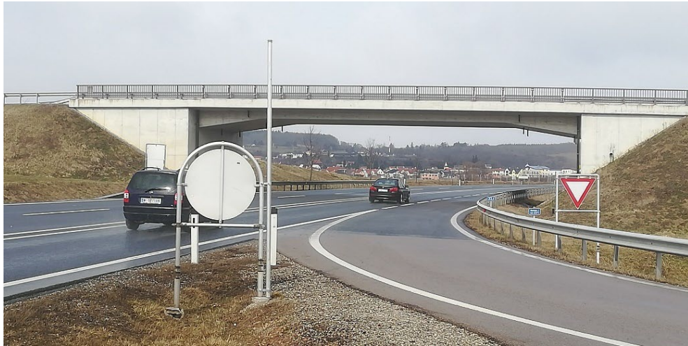
Abb. 5-4: Beispiel einer Vorbereitung mit einem Steher neben dem Verkehrszeichen bei Maissau 1
