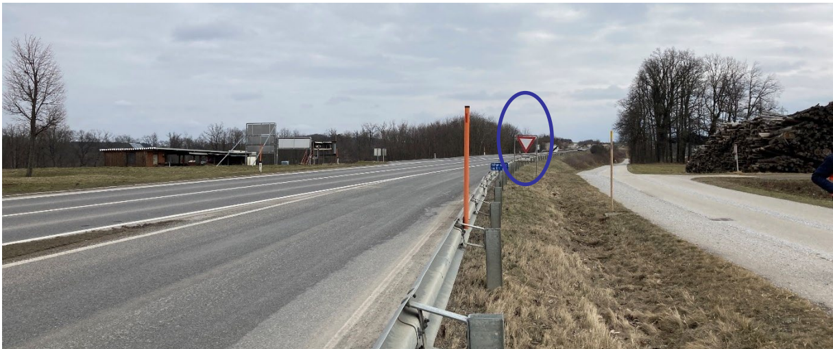
Abb. 4-13: Anfang des Beschleunigungsstreifens in Gföhl 2: Geeignetes Verkehrszeichen
