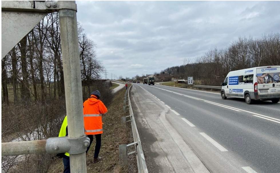
Abb. 4-16: Blick vom Ende des Beschleunigungsstreifens in Gföhl 2 vom geeigneten Verkehrszeichen entgegen die Fahrtrichtung
