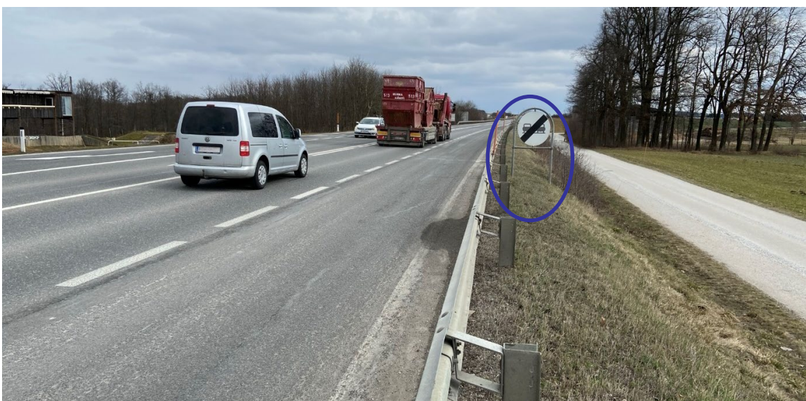
Abb. 4-15: Mittlerer Abschnitt des Beschleunigungsstreifens in Gföhl 2 mit geeignetem Verkehrszeichen
