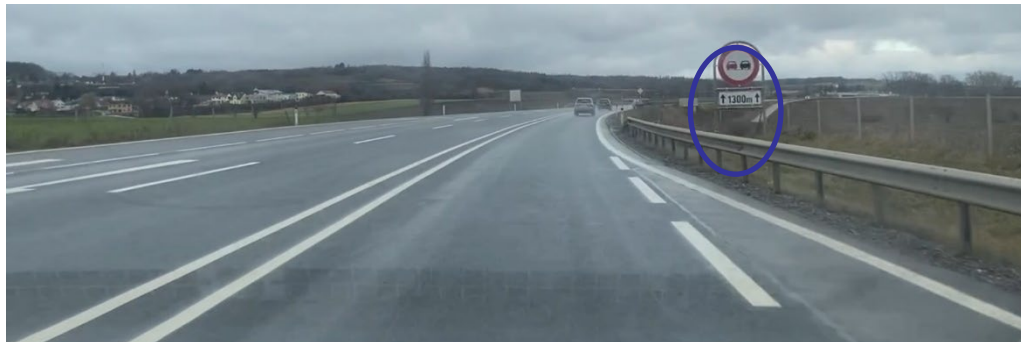
Abb. 4-21: Ende des Beschleunigungsstreifens, Verkehrszeichen zur möglichen Installation des Messequipments
