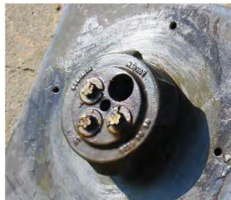
**Abb. 2:** Links: Aufbau eines Ankers (Burtscher et al.); Rechts: Detail Kopfausbildung
