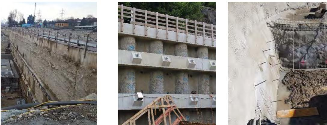
**Abb. 1:** Anwendungsgebiete für Anker und Zugelemente in der Geotechnik; Links: Baugrubenverbau; Mitte: Stützbauwerk; Rechts: Nagelwand
