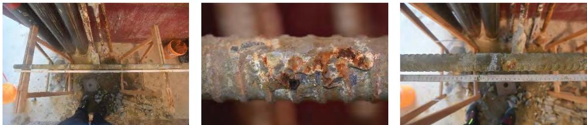
**Abb. 65:** Links: Ganzer Bewehrungsstab mit Meterstab, Mitte: Korrosion mittig im Stab, Rechts: Einfluss Abstandhalter
