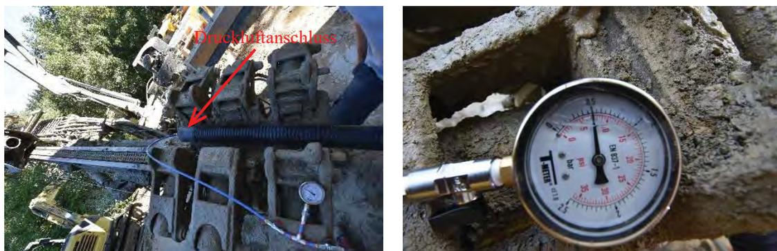
**Abb. 39: Überprüfung Anker 2 nach dem Einbau**
