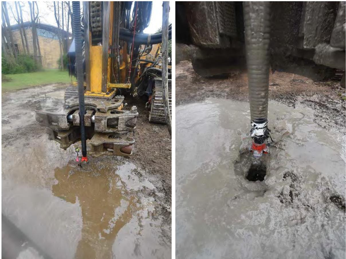
**Abb. 25:** Validierung DCP-SBZ; Einbau der Probekörper im Feldversuch (links); Detail Bohrkronen nach Einbau (rechts)
