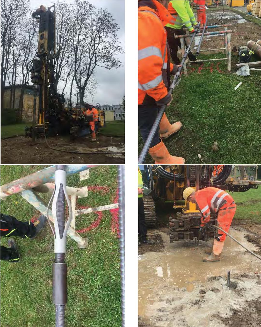
**Abb. 118:** Bilder der Herstellung der Probe-Mikropfähle; Bohrgerät Klemm (oben links); Zusammenbau Mikropfahl (oben rechts); Muffenverbindung (unten links); Verfüllen des Bohrloches mit Zementsuspension (unten rechts)
