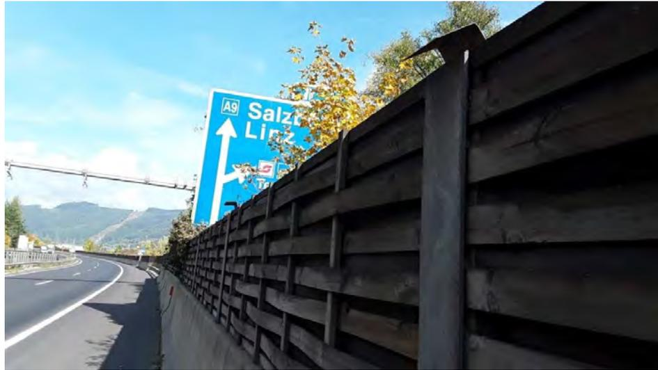
**Abbildung 2: Beispiel LSW auf Betonleitwand (Foto ASFINAG)**
