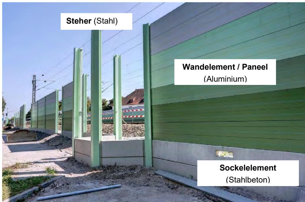
Abbildung 3: Bild Lärmschutzwand (Foto VCE)
