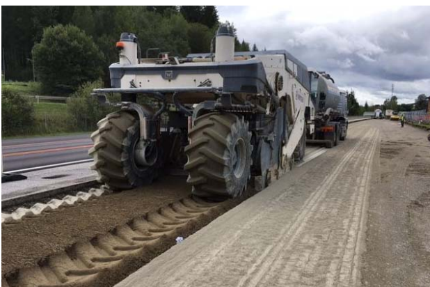
ABB 1. Fugenlose Herstellung einer zementstabilisierten Tragschicht im Rahmen der Bautype AS4
