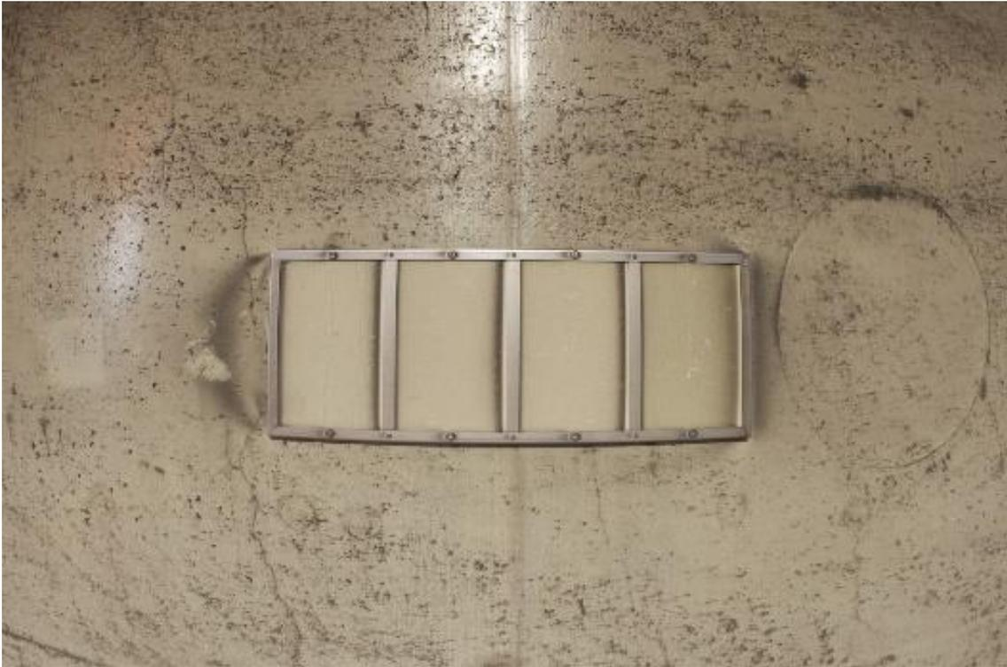
**Abbildung 50: Musterplatten im Plabutsch-Tunnel (verschmutzt)**
