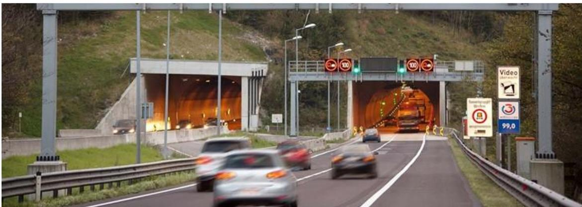
**Abbildung 77: Helle Einfahrtsbeleuchtung bei Tageslicht (Quelle: ASFINAG)**
