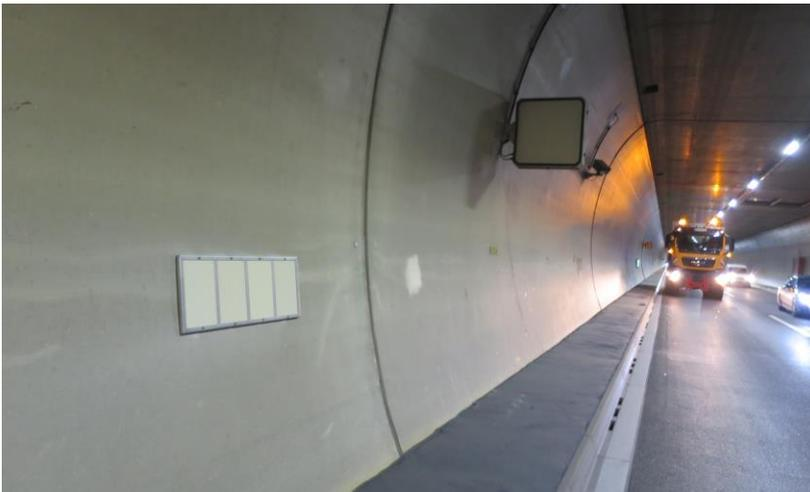
ABB 2. Montierte Musterplatte im Tunnel mit unterschiedlichen Oberflächen
