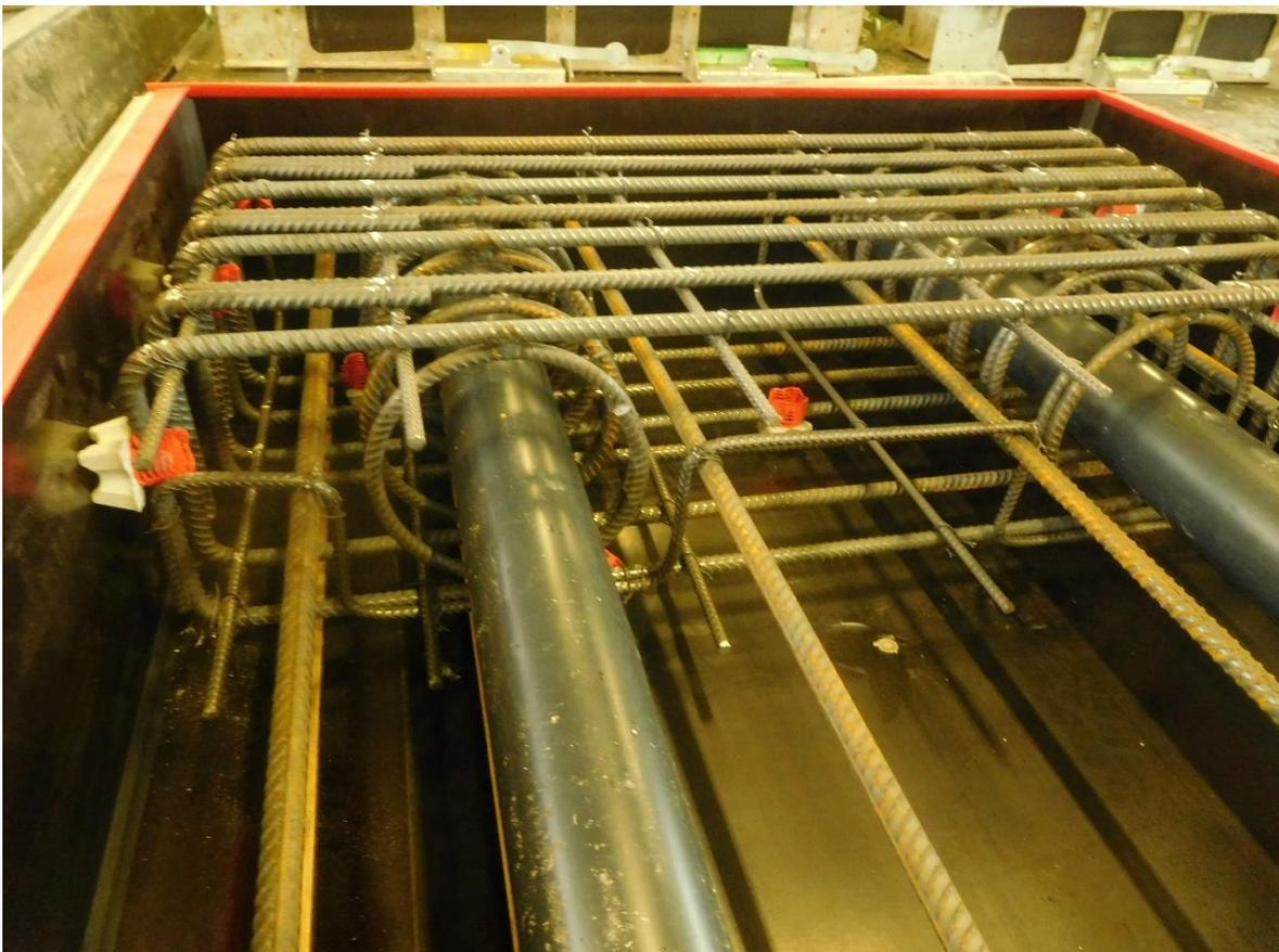
**Abbildung 32: Foto Bewehrungsabnahme aus dem Fertigteilwerk**
