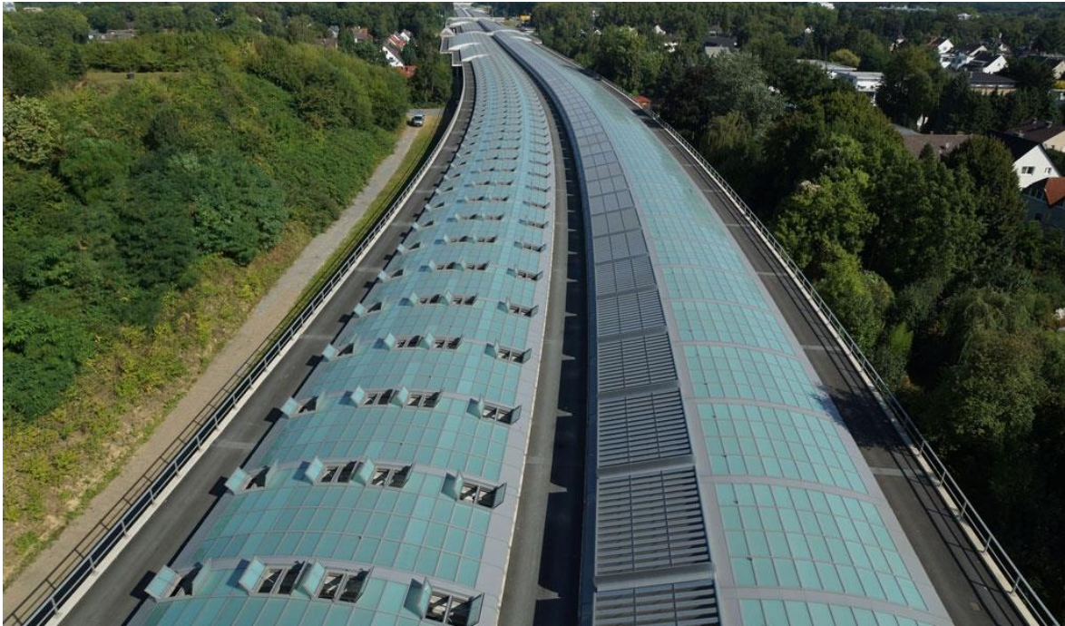
Abbildung 4: Draufsicht der Lärmschutzeinhausung der A1 in Köln Lövenich. 3
