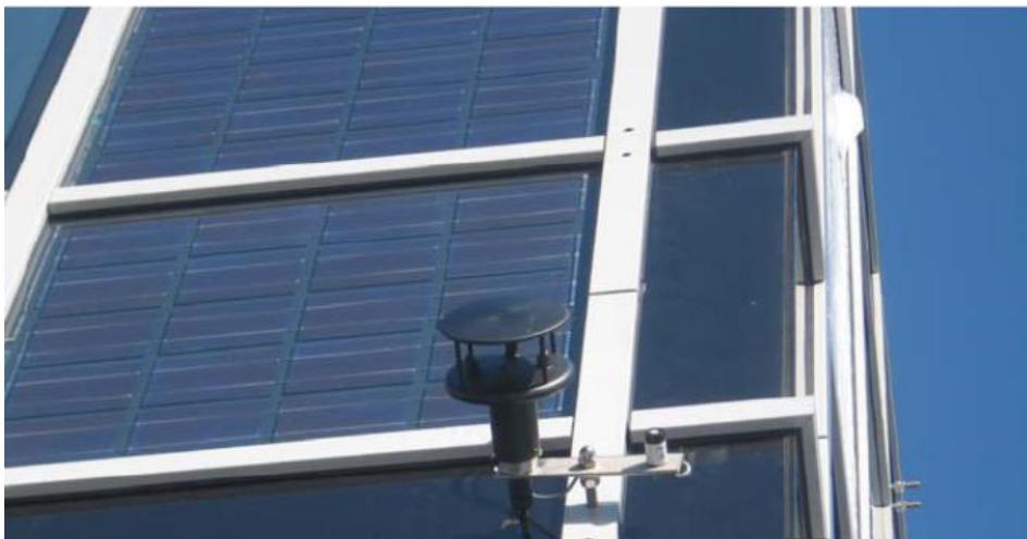
Abbildung 79: 2D-Doppler-Anemometer an einer PV-Testfassade
