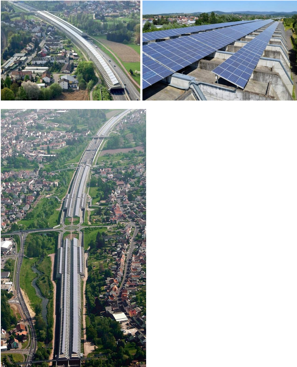
Abbildung 1: Ansichten der Autobahn-Einhausung mit PV Anlage entlang der A3 bei Aschaffenburg. Foto: Rüdiger Dunker (dpa) Quelle: www.hna.de
