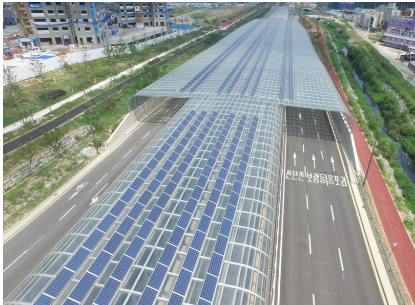
Abbildung 6: Ansichten der Schallschutzeinhausung in Korea mit aufgesetzten PV Modulen. 5
