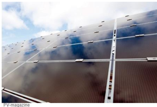
Abbildung 30: Dünnschicht-PV (z.B. CIGS, CdTe oder OPV). Neben der Lichtabsorption durch Silizium gibt es auch andere (Halbleiter)materialien, die für Solarzellen eingesetzt werden können. Die hierbei eingesetzten Absorberschichten sind in der Regel wesentlich dünner als Silizium-Solarzellen und werden daher auch als "Dünnschicht-PV" bezeichnet. Dadurch sind sie in der Regel ebenfalls flexibel. Durch die zumeist höheren Kosten bezogen auf den Wirkungsgrad werden sie vor allem in spezialisierten Anwendungen eingesetzt.
