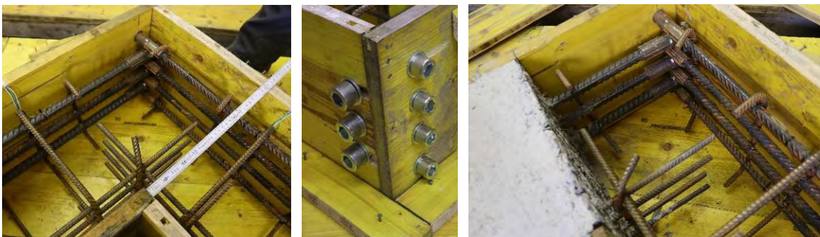
Abbildung 127: Eckbewehrung (links), Schraubenpositionen (Mitte) und Ansicht nach der Betonage des ersten Schenkels (rechts) des Versuchskörpers P07-01.
