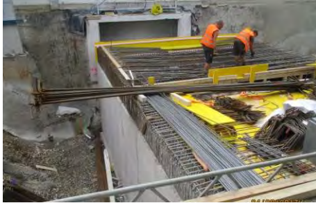
Abbildung 41: Umbau BHF Seefeld – auskragende Bewehrung. (STRABAG AG und Fröschl AG & Co. KG / Baumeisterarbeiten Umbau Bahnhof Seefeld)
