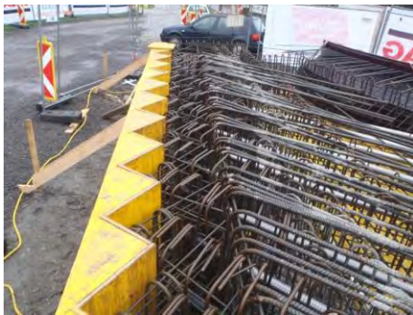
Abbildung 43: Wendebrücke Mayrhofen – auskragende Bewehrung. (Baumeisterarbeiten Wendebrücke Dornastraße (ARGE LANG-STRABAG))
