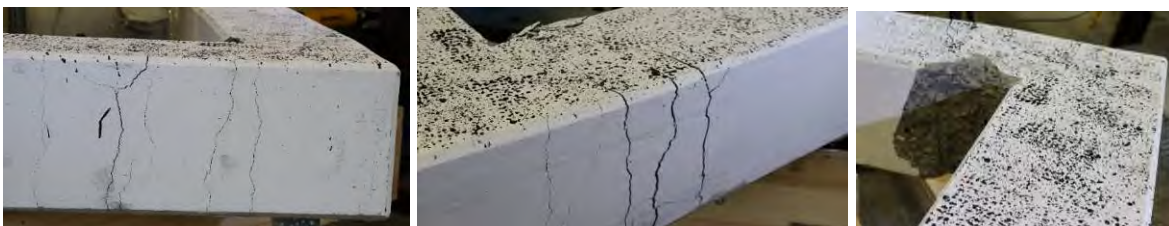
Abbildung 95: Rissbildung im Verlauf der Belastung (links und Mitte) und Druckzone nach dem Versagen (rechts).
