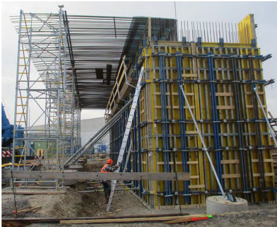
Abbildung 1: Auskragende Rahmeneckbewehrung einer im Bau befindlichen Brücke (entnommen aus [1]).
