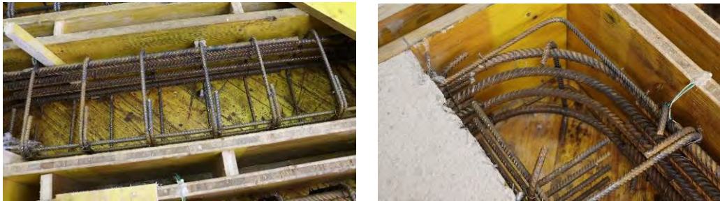
Abbildung 111: Übergreifungsstoß (links) und Ansicht nach der Betonage des ersten Schenkels (rechts) des Versuchskörpers P02-01.
