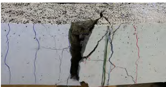
Abbildung 189: P04-01 Biegezugbereich nach dem erfolgten Versagen.
