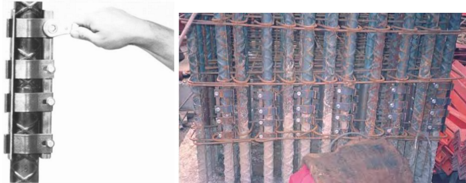
Abbildung 27: System mit Strap-Type Coupling Sleeve (links, entnommen aus [23]) und (rechts, entnommen aus [24]).
