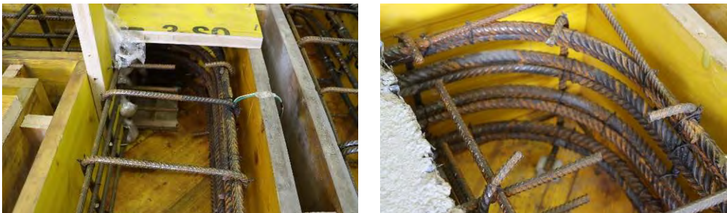
Abbildung 117: Übergreifungsstoß (links) und Ansicht nach der Betonage des ersten Schenkels (rechts) des Versuchskörpers P04-01.
