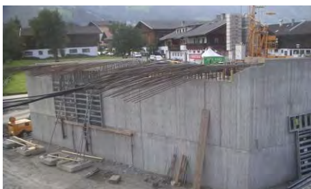
Abbildung 39: Knoten Uderns – Widerlager.
