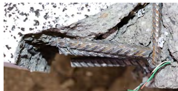
Abbildung 190: P04-01 Verdrehung des Bewehrungsstoßes und Betonausbruch.
