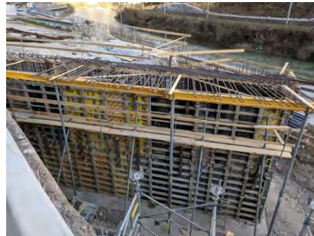
Abbildung 36: Rahmentragwerk Bad Ischl.
