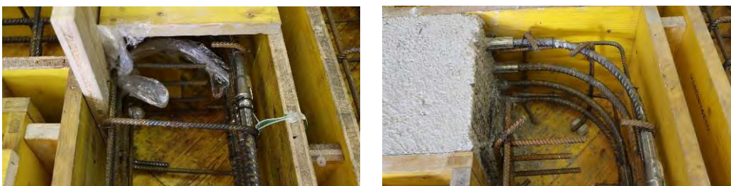
Abbildung 113: Übergreifungsstoß (links) und Ansicht nach der Betonage des ersten Schenkels (rechts) des Versuchskörpers P03-01.
