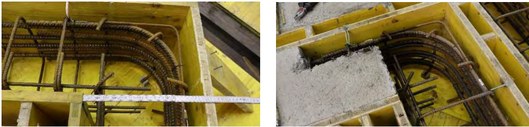
Abbildung 120: Übergreifungsstoß (links) und Ansicht nach der Betonage des ersten Schenkels (rechts) des Versuchskörpers P05-01.
