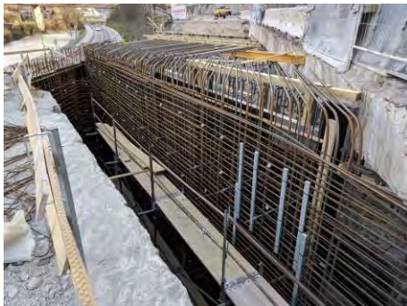
Abbildung 37: Rahmentragwerk Bad Ischl – Bewehrung.
