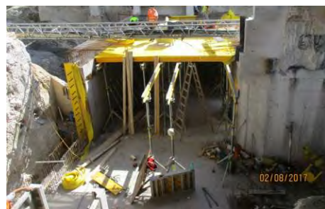
Abbildung 40: Umbau BHF Seefeld – Tragwerkschalung. (STRABAG AG und Fröschl AG & Co. KG / Baumeisterarbeiten Umbau Bahnhof Seefeld)
