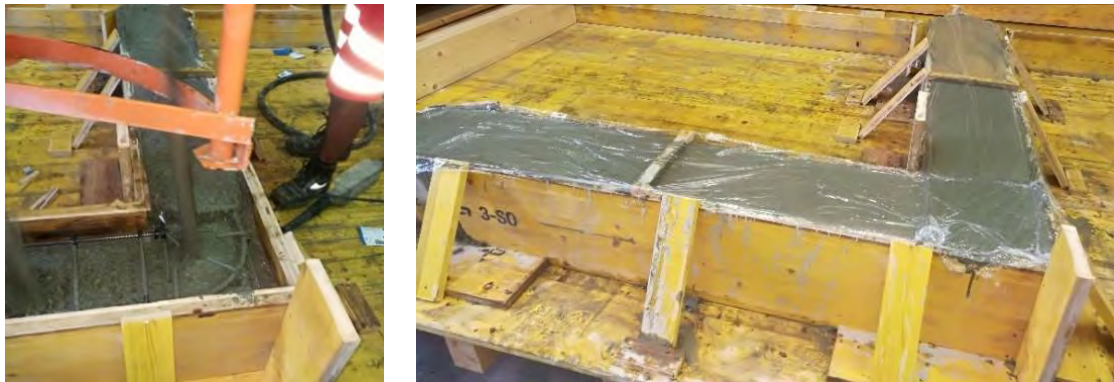
Abbildung 93: Betonage beider Schenkel in einem Guss mit Fuge nass in nass (links) und fertig betonierter und zur Nachbehandlung abgedeckter Versuchskörper (rechts).
