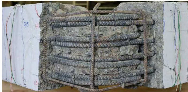
Abbildung 211: Schlaufenstoß nach dem erfolgten Versagen.
