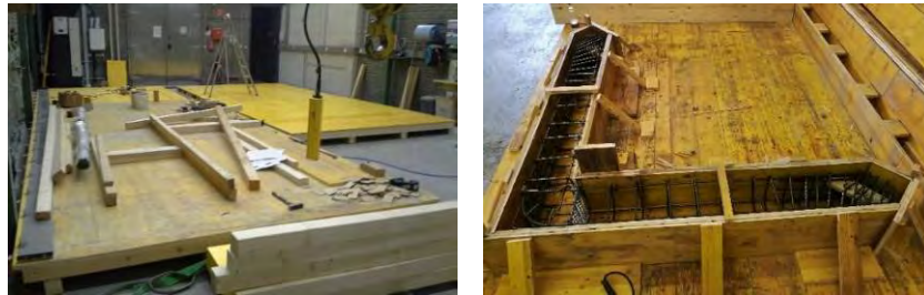
Abbildung 90: Schalboden (links) und fertige Schalung mit Bewehrungskorb (rechts).
