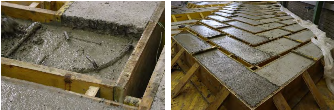
Abbildung 130: Betonage eines Tragwerkschenkels (links) und Versuchskörper nach der 2. Betonage (rechts).
