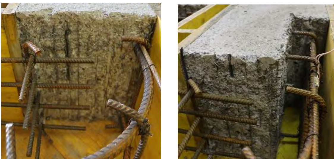
Abbildung 129: Fugen nach der Betonage des ersten Schenkels für die Standardvariante (links) und für die z-Fuge (rechts).
