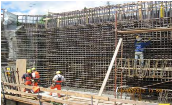
Abbildung 35: Tutzing – Bewehrung des Widerlagers.
