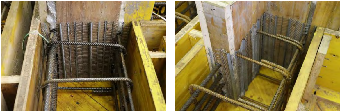
Abbildung 128: Fugenschalung mit Streckmetall für die Standardfuge (links) und für die z-Fuge (rechts).
