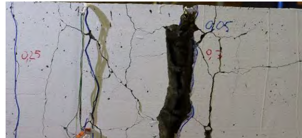
Abbildung 178: P03-03 Biegeriss nach Versagen mit Betonausbruch.
