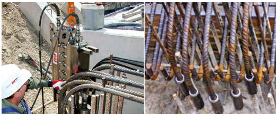
Abbildung 17: Fließpressmuffenstoß System FLIMU der Firma DSI (entnommen aus [18]).
