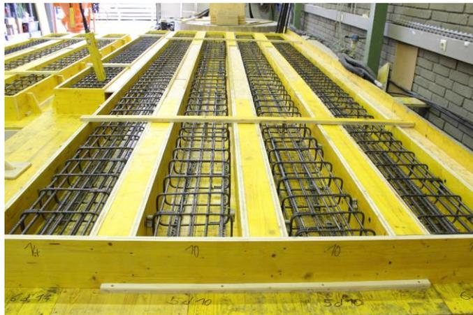
**Abbildung 92: Schalung und Bewehrung der Versuchskörper**
