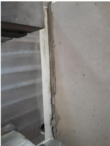
**Abbildung 38: Toleranzausgleich mit Mörtelfuge**
