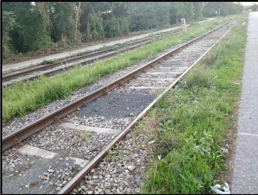
**Abbildung 24: Aufnahme vom 09.09.2020 (etwa 7 Wochen nach der Behandlung) einer mit Elektroherbizid am 23.07.2020 behandelten Fläche. Der schmale Streifen links des Gleises war auch vorher schon spärlich bewachsen. Der Streifen rechts des Gleises ist schon wieder vollständig bewachsen.** Quelle: Grigull (E.C.O.)
