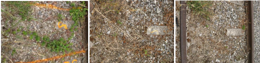
Abb. 5 d-f: Gleiszwischenraum/ Variante 3: Beloukha®
