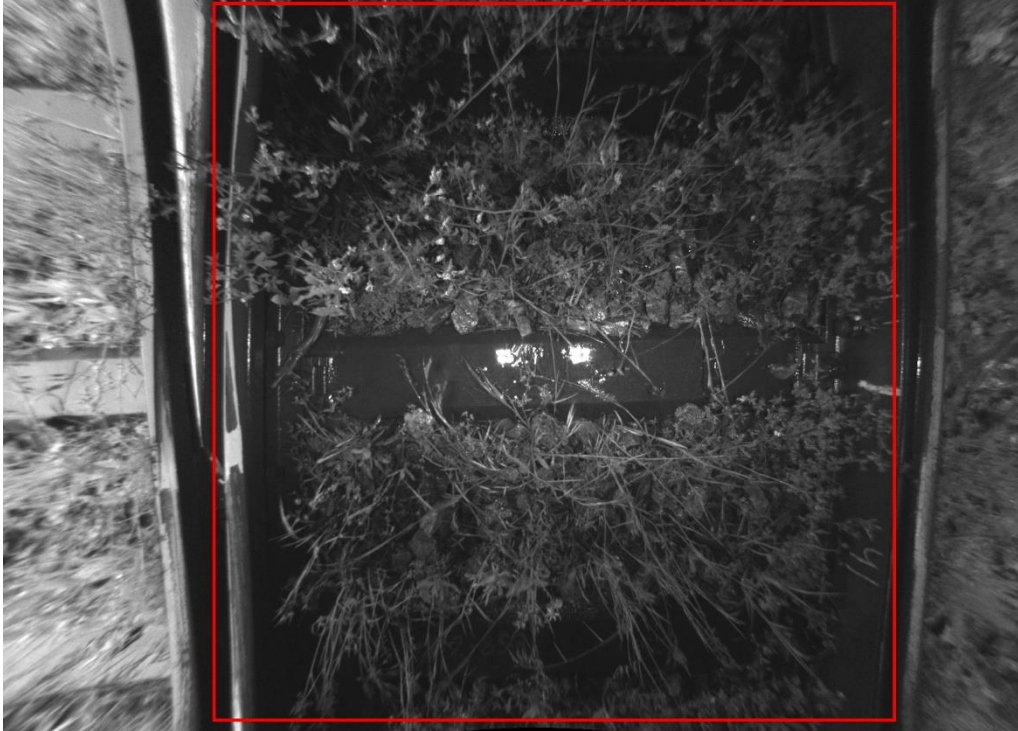
Abb. 18: Bewuchs am Gleiskörper [3]
