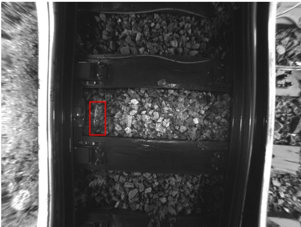
Abb. 49: Flasche links im Bild, entzerrtes Bild mit erkanntem Objekt
