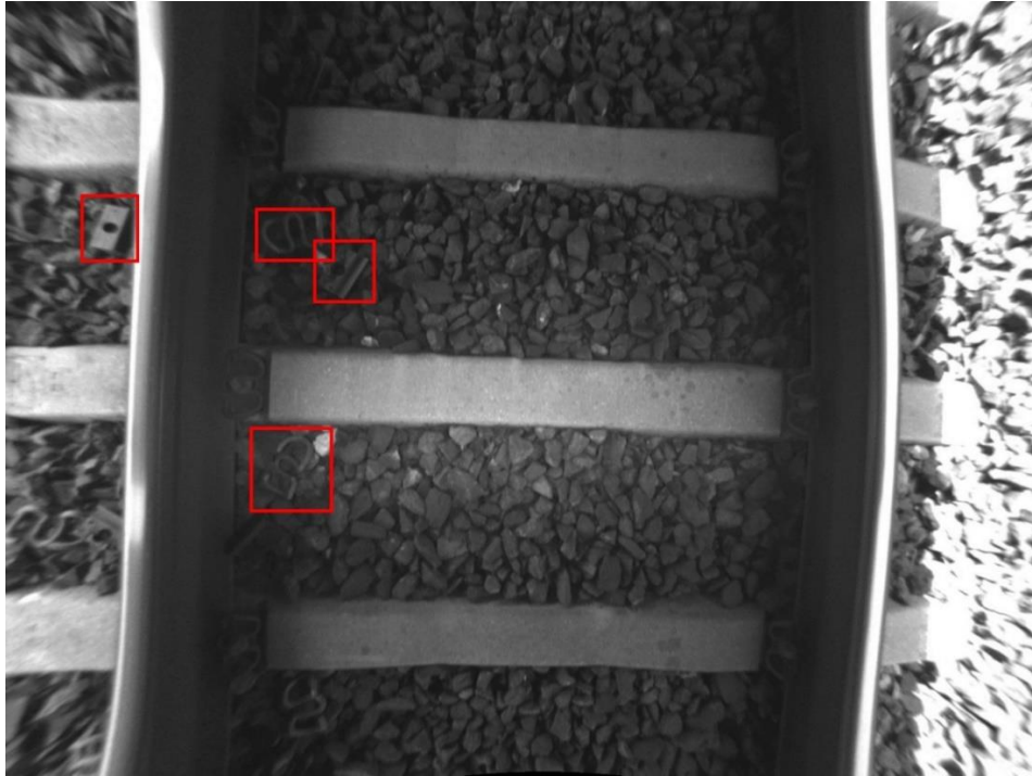
Abb. 46: Gelöste Spanklemmen und Winkelführungsplatten, entzerrtes Bild mit erkannten Objekten
