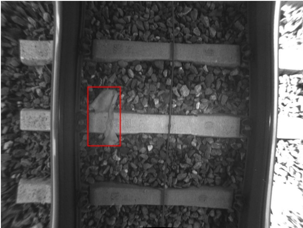
Abb. 48: Fremdkörper am Gleis, entzerrtes Bild mit erkanntem Objekt
