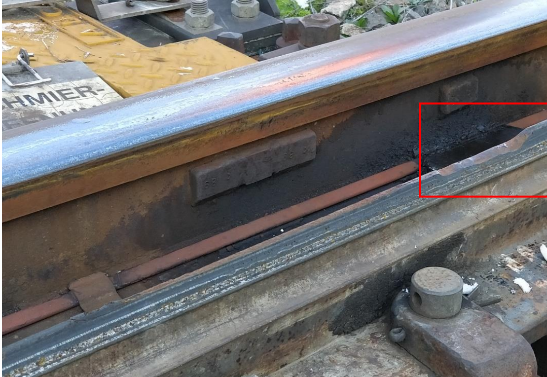
Abb. 3: Weichenzunge mit Abrieb [3]
