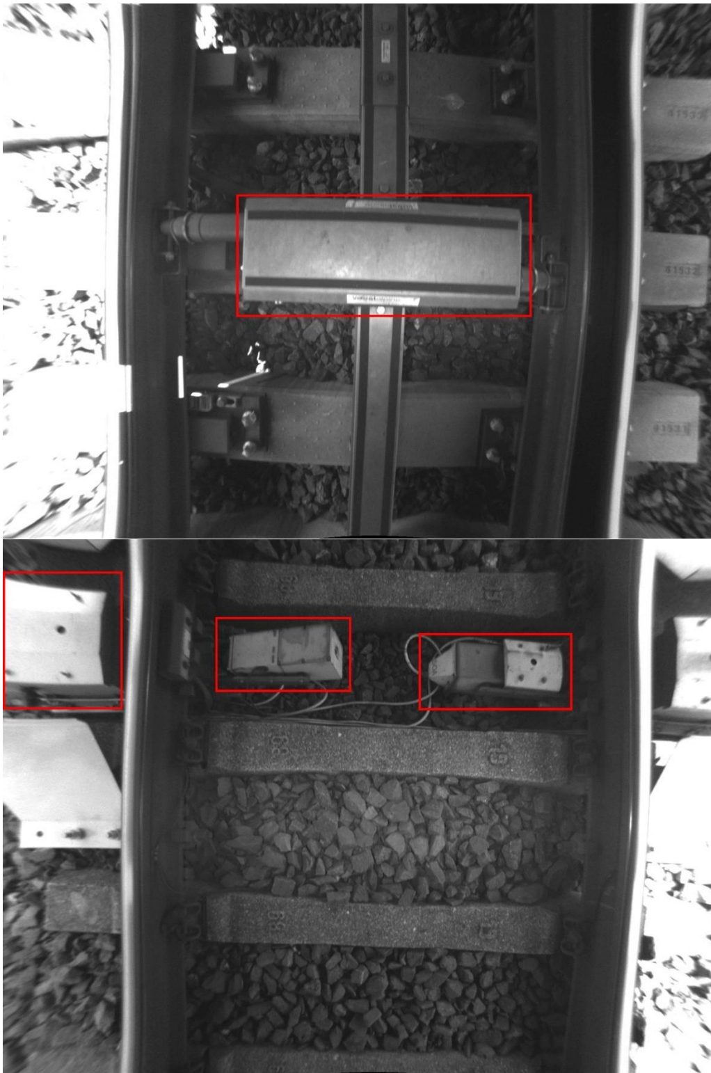
Abb. 43: Entzerrte Bilder mit erkannten Weichen-Schaltkästen
