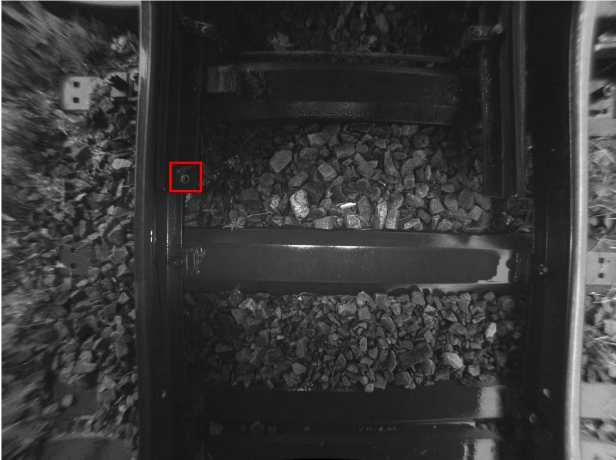
Abb. 44: mögliche fehlende Schraube, entzerrtes Bild
