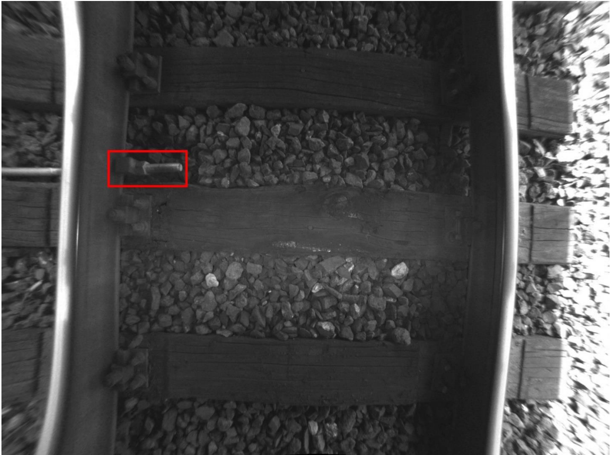
Abb. 52: Schraube zur Befestigung der Schiene
