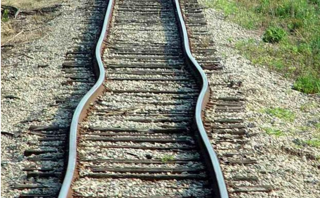
Abb. 9: Gleisverwerfung [8]
