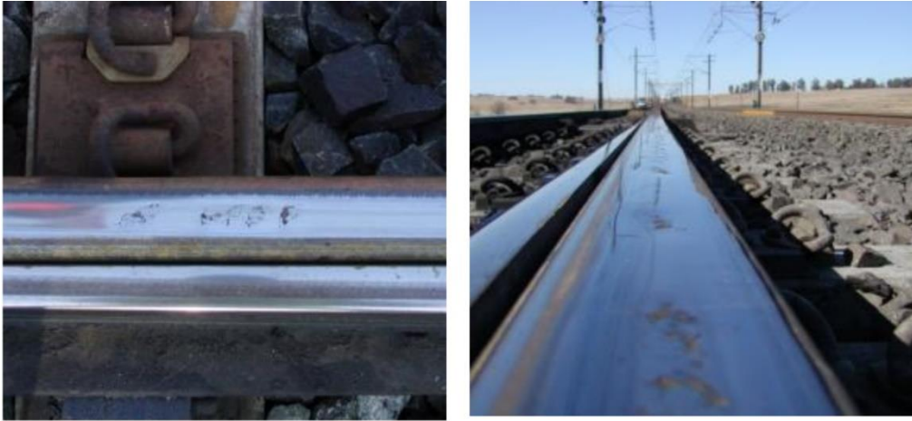
Abb. 13: Ablättern der Schiene [4]
