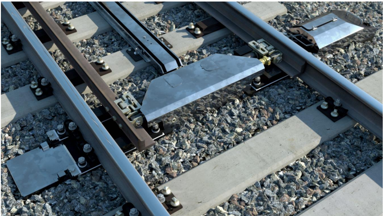
Abb. 6: Weiche mit intakten Abdeckungen [5]
