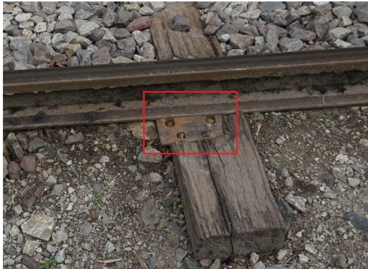
Abb. 16: Fehlende Schrauben [3]
