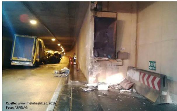
Abbildung 24: Freigelegte Kante der Tunnel-Pannenbucht durch Verschieben der Absicherungsmaßnahme
