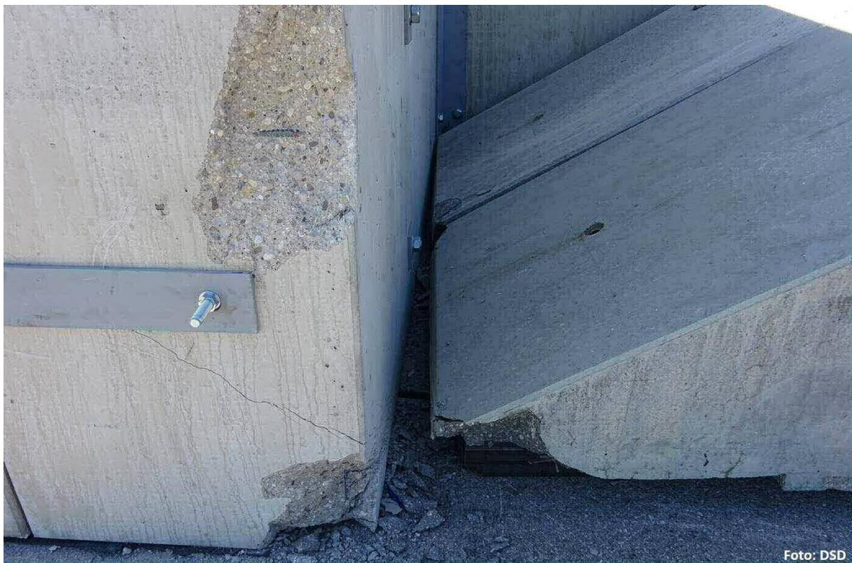
Abbildung 50: Anprall der rückwärtigen Abstützung an der massiven Mauer "BMV17004"
