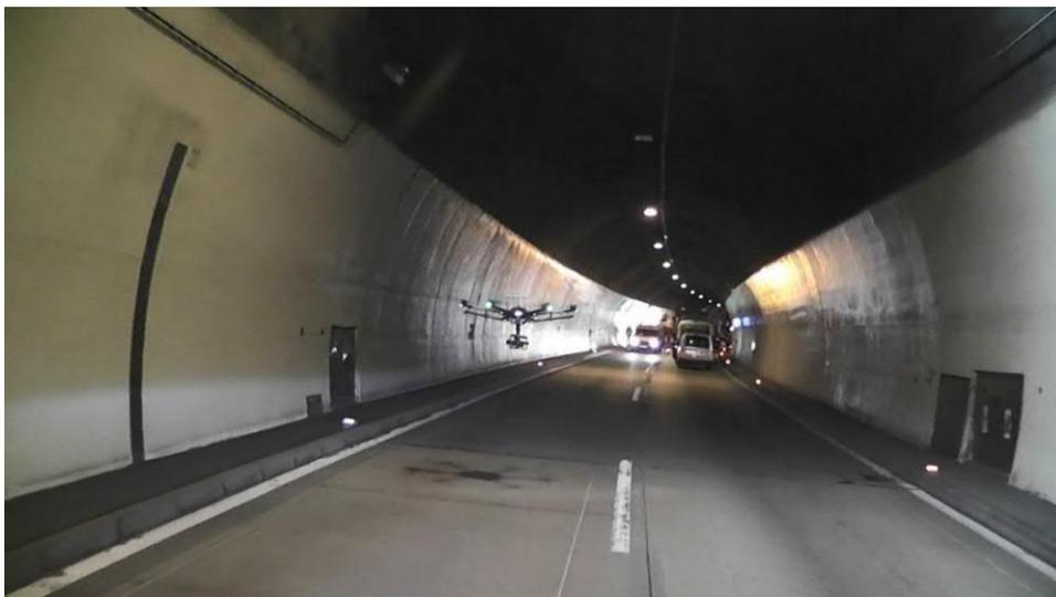
Abbildung 190: Teststellung zur Erfassung des Unfallgeschehens im Tunnel (Ausfall der Überwachungskameras symbolisiert)
