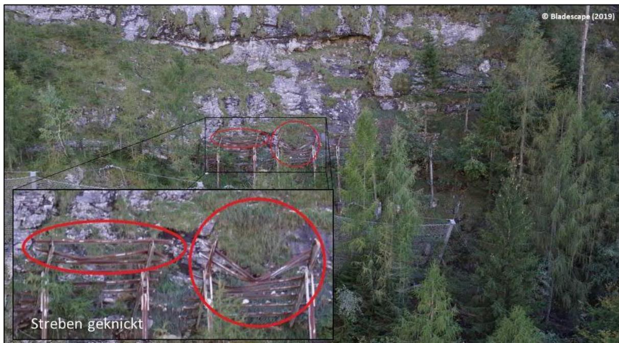
Abbildung 99: Schutzverbauung Klammstein – Beispiel Schäden Verbauung (alt)
