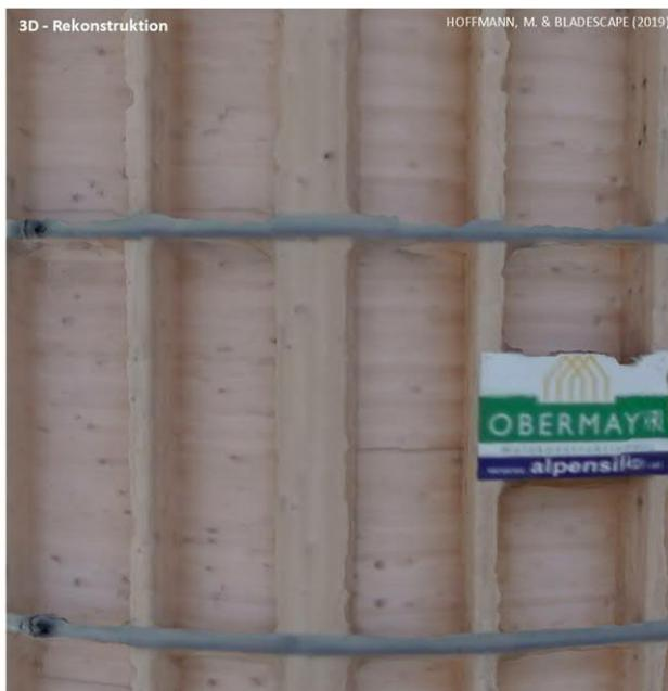
Salzsilo 3D – Details Textured Mesh (High quality processing) – verwaschene Textur und Trägerstruktur mit toten Sichtwinkeln aus der fotogrammetrischen Rekonstruktion
