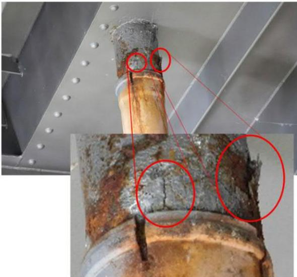
Starke Korrosion mit Abplatzung und Undichtheit, Bruch und Folgeschäden zu erwarten → Austausch bei nächster IH.
