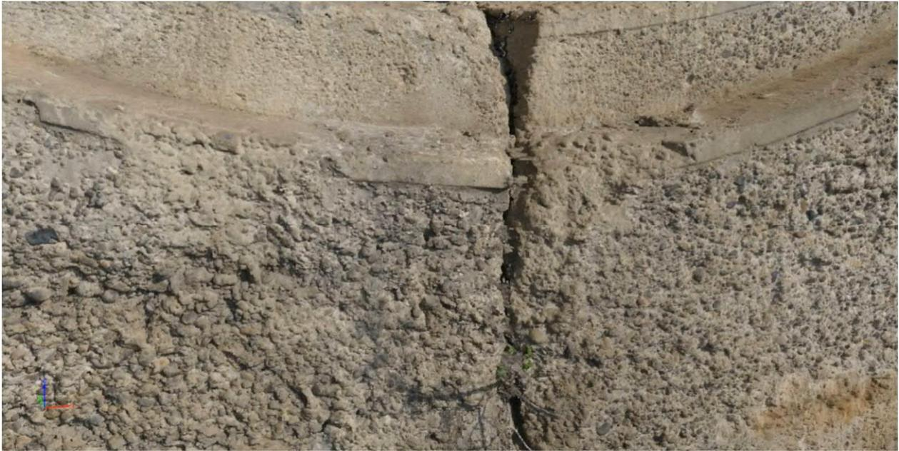
Abbildung 43: Punktwolke - Nahansicht eines Risses in Bogen 34 (Italienschleife - Bogen 34)
