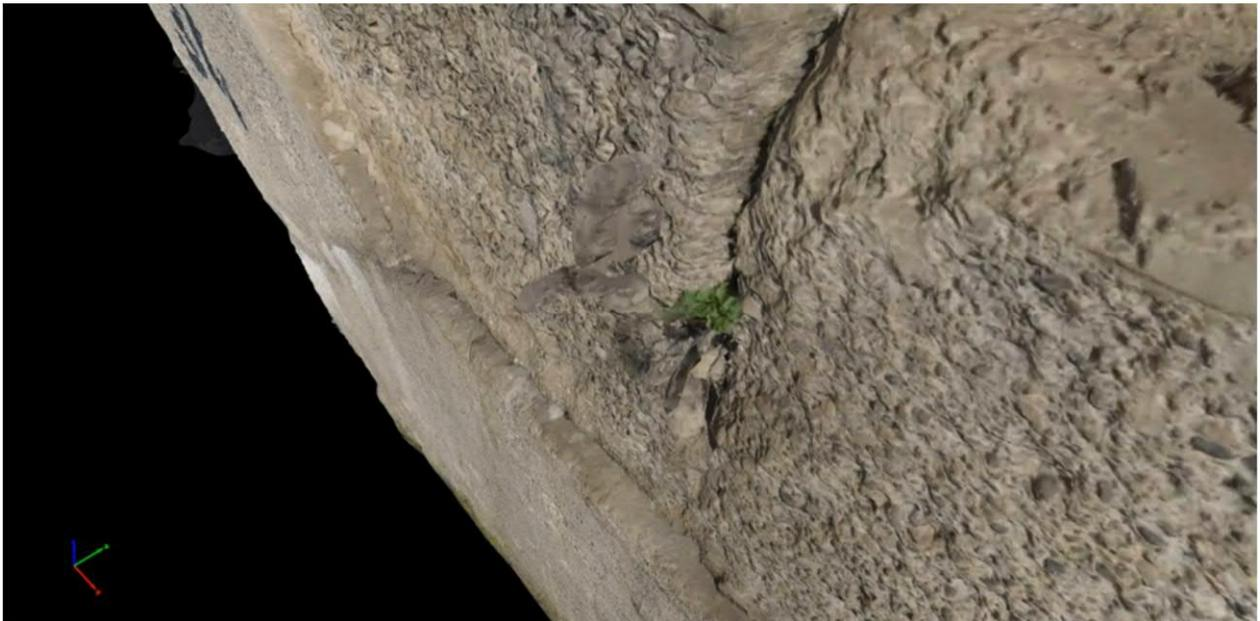
Abbildung 44: Nahansicht des Risses im texturiertem 3D Modell (Italienschleife - Bogen 34)
