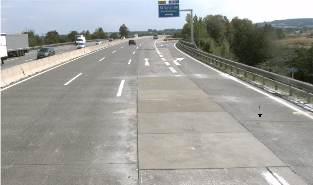
**Abbildung 152: Rechteckige Fertigteile nach dem Einbau, beim zweiten Fertigteil ist rechts der Schnitt zur Ausleitung der optischen Kabel erkennbar.**
