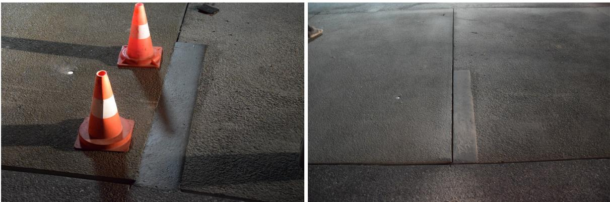
**Abbildung 92: Mit Reparaturmörtel reparierte Schadstelle im Fertigteil**
