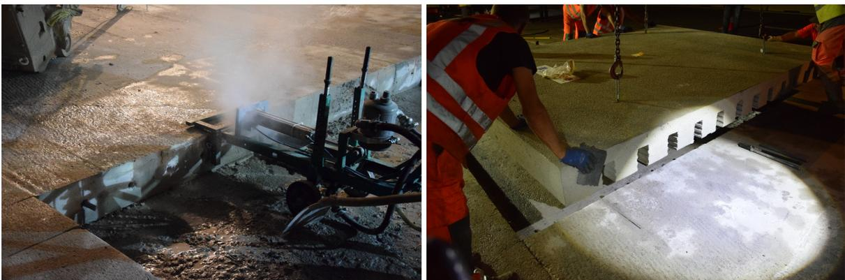
**Abbildung 94: Übergang zum Bestand mit Dübel/Dübelkammern**
