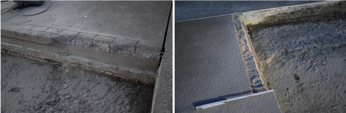
**Abbildung 91: Schadstelle im Fertigteil**
