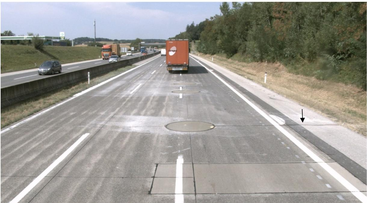
**Abbildung 151:** Runde Fertigteile nach dem Einbau, beim ersten Fertigteil rechts ist der Schnitt zur Ausleitung der optischen Kabel erkennbar.
