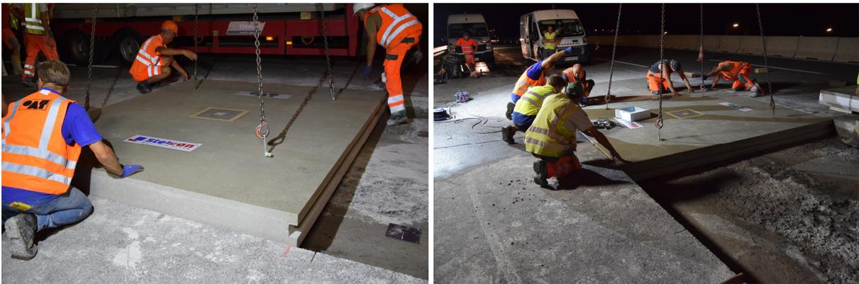
**Abbildung 89: Einsetzen der Fertigteile**
