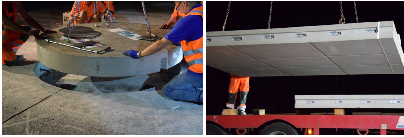
ABB 2. Fertigteile beim Einbau
