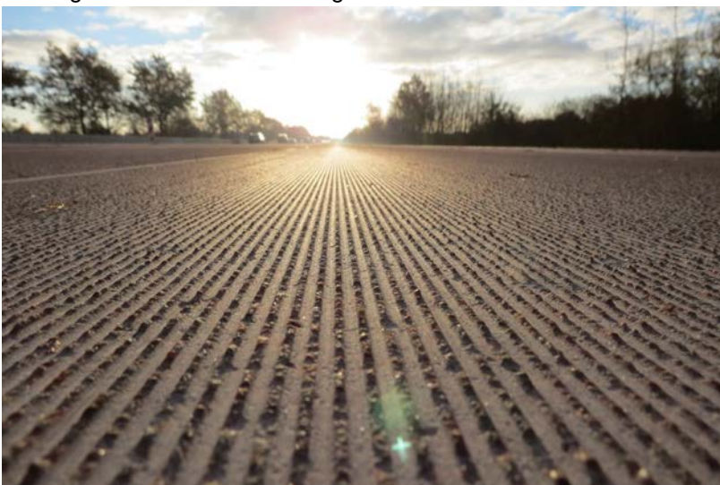
ABB 1. Texturgrinding auf Beton
