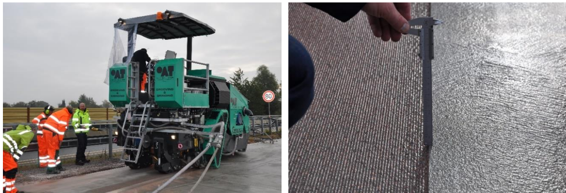
Abbildung 4: Grindingarbeiten auf der BAB A23
