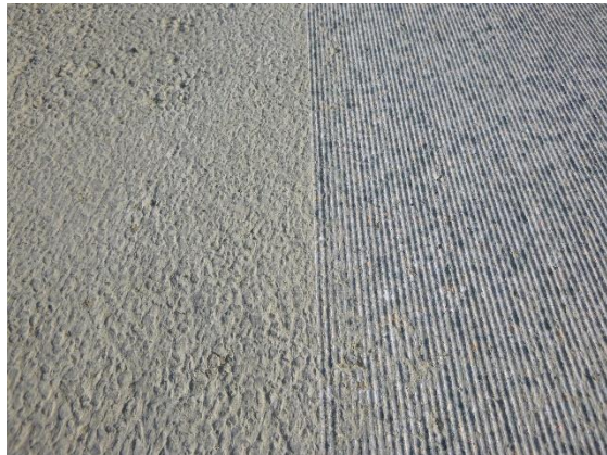
Abbildung 97: Grindingtextur 2,8/2,2 Station km 40,625
