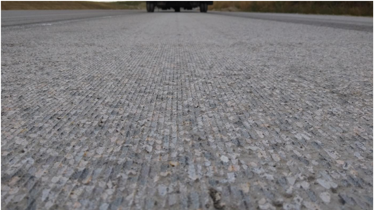
Abb. 7: Grindingoberfläche Fläche 2 Station km 40,975 RF Wien
