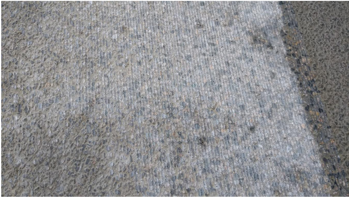
Abb. 3: Grindingoberfläche Fläche 1 Station km 40,625 RF Wien
