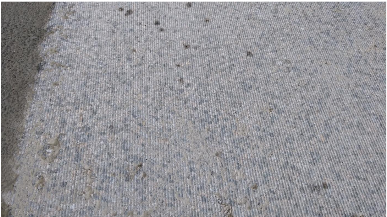
Abb. 4: Grindingoberfläche Fläche 1 Station km 40,625 RF Wien
