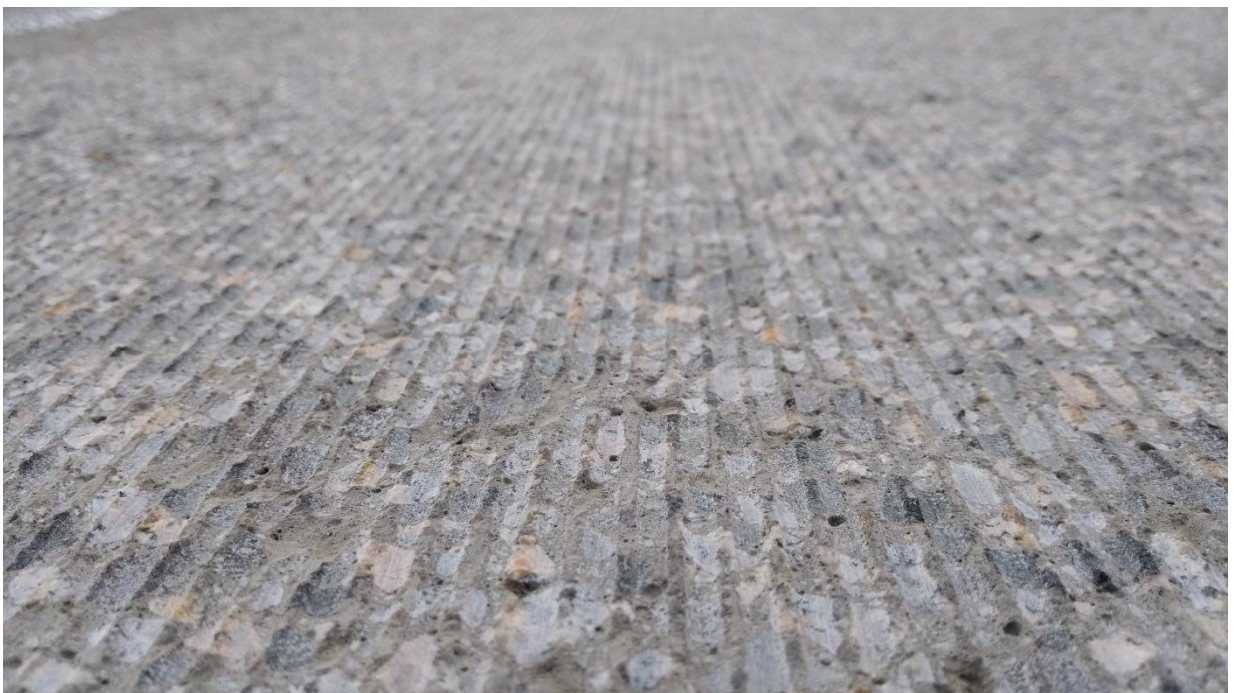
Abb. 8: Grindingoberfläche Fläche 2 Station km 40,975 RF Wien
