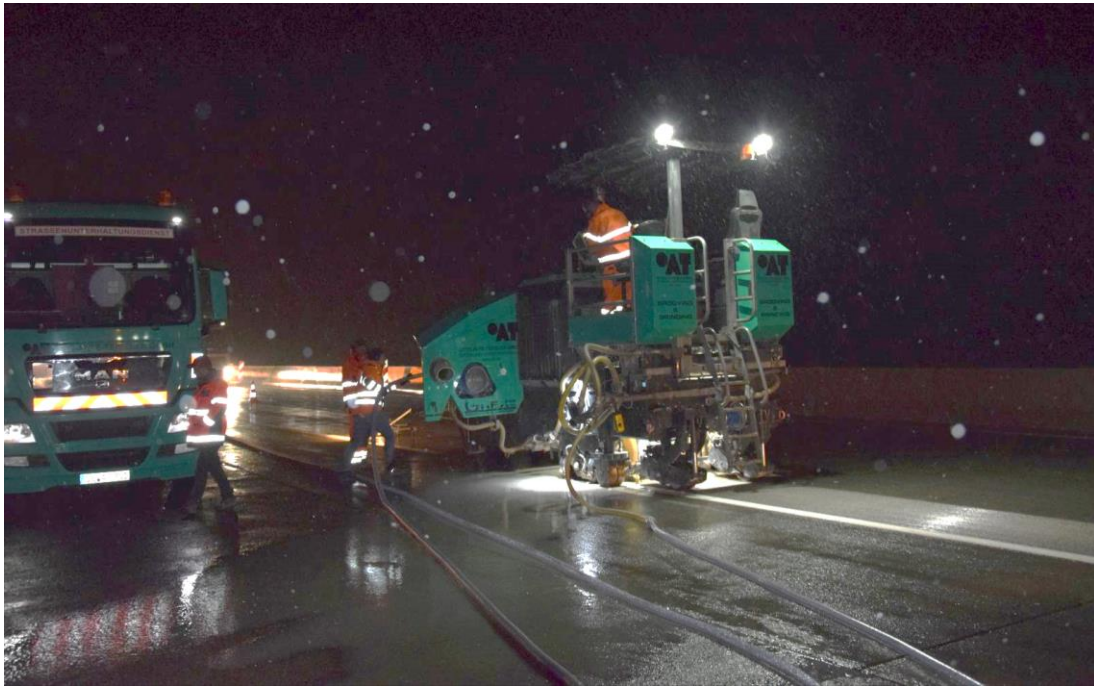
Abbildung 102: Herstellung der Grindingtextur auf der Versuchsstrecke A10 bei Schneefall.
