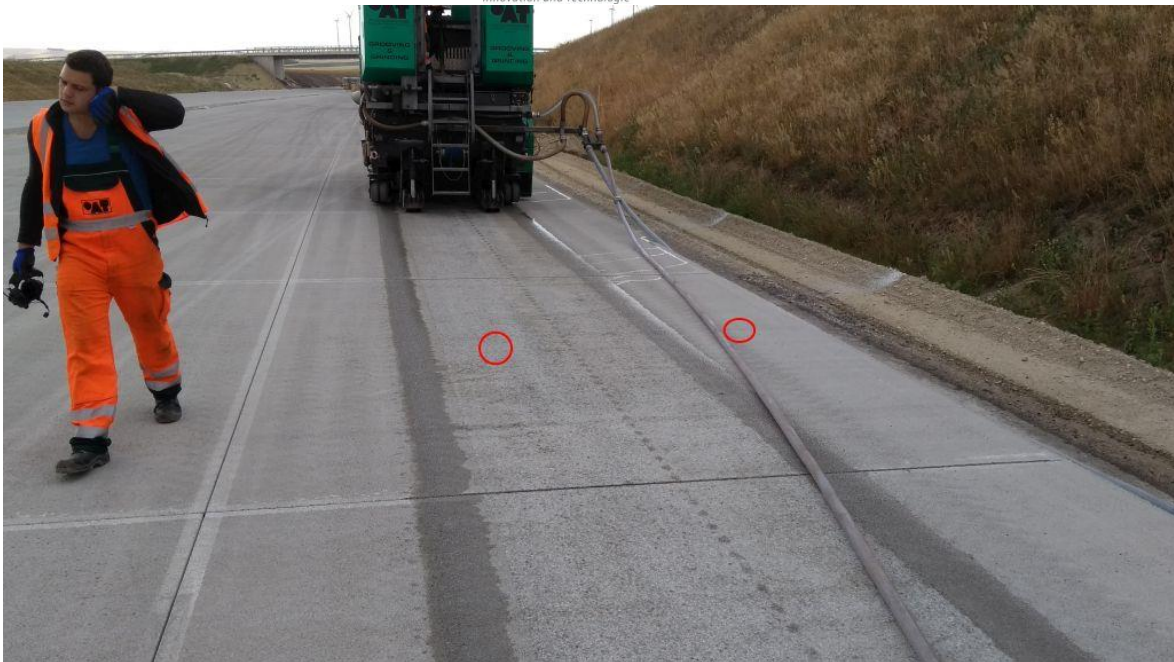
Abbildung 118: Probegrinding auf der A5 und Lage der Bohrkern für die Laboruntersuchung
