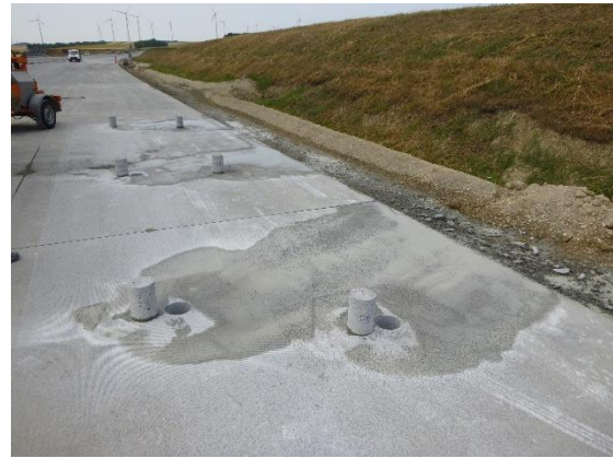
Abbildung 98: Bohrkernproben A1 bis C2 Station km 40,625
