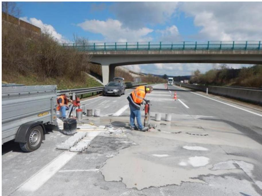
**Abbildung 3-8: Entnahme der Bohrkern**
