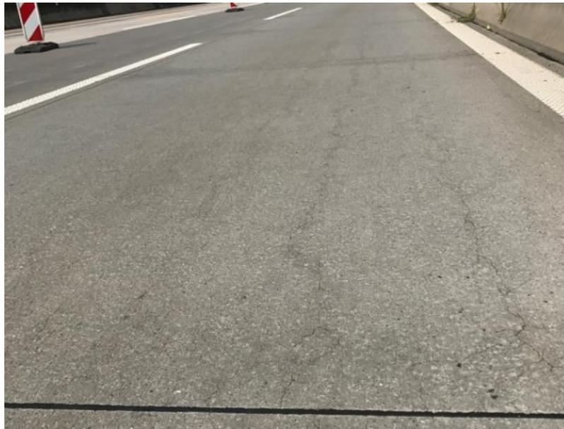
**Abbildung 3-21: Fahrbahnschäden – Längsrisse in der Plattenmitte**
