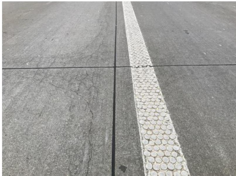
**Abbildung 3-20: Fahrbahntextur und AKR-Schäden an den Plattenkreuzen**
