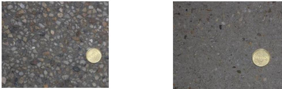
**Abbildung 3-5: Oberflächentextur der Probenentnahmefelder (links 1. Fahrstreifen, rechts Pannestreifen)**
