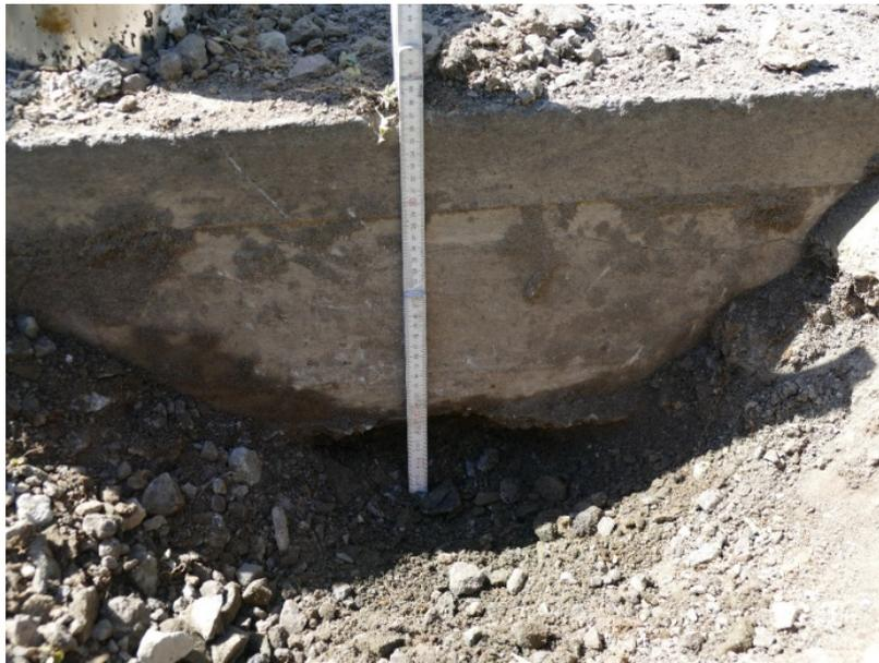
**Abbildung 3-17: Vertikaler Aufbau der Fahrbahn**
