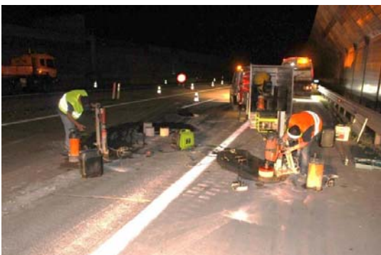
ABB 1. Bohrkernentnahme A1/A21
