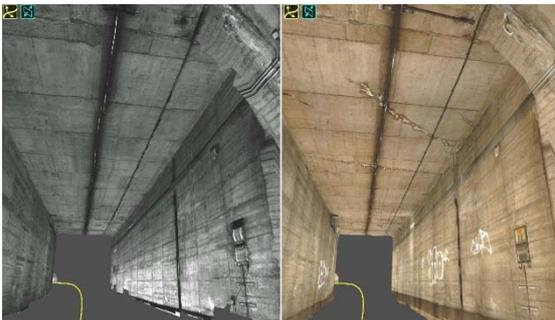
Abbildung 7: Vergleich 3D-Modell der Null-messung mit der Folgemessung
