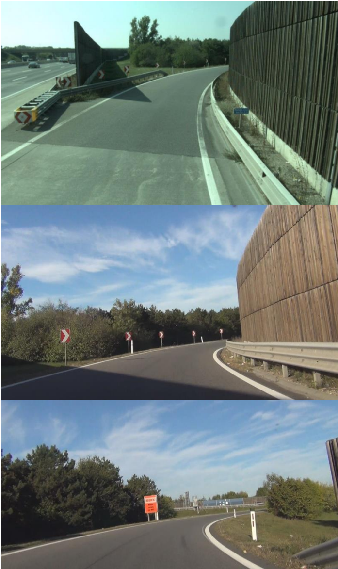
Foto 9: A 2 Süd Autobahn Ausfahrt ASt Baden Fahrtrichtung Graz
