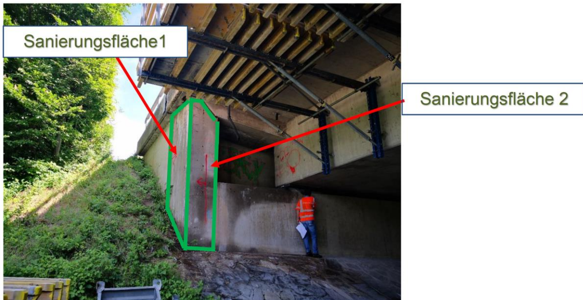
Abbildung 6.5: Übergang von Sanierungsfläche 1 zu Sanierungsfläche 2
