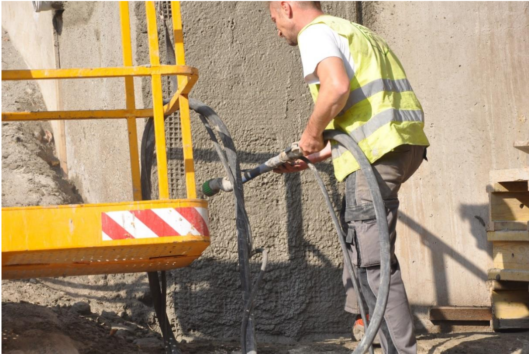
Abbildung 6.16: Einbringen der Textilien durch Laminieren und Sprühen der zweiten Feinbetonschicht (1,5 cm)
