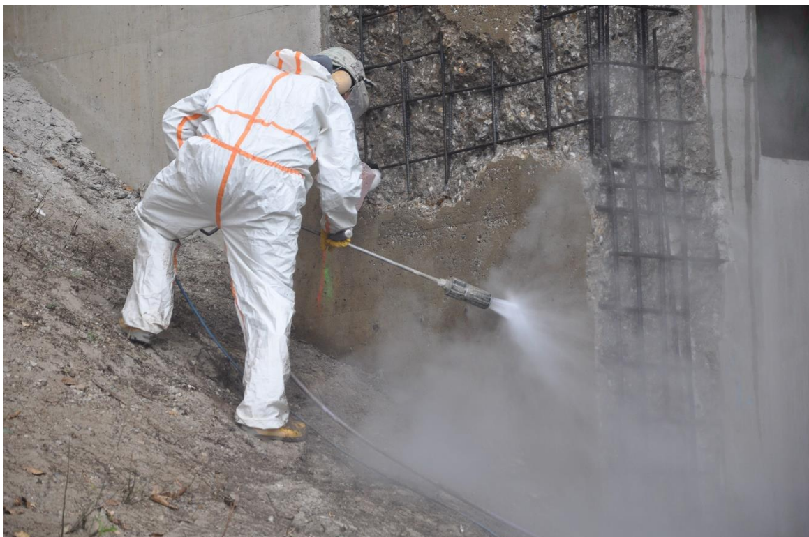
Abbildung 6.11: Vorbereiten der Sanierungsflächen durch Wasserstrahlung bei 2500 bar
