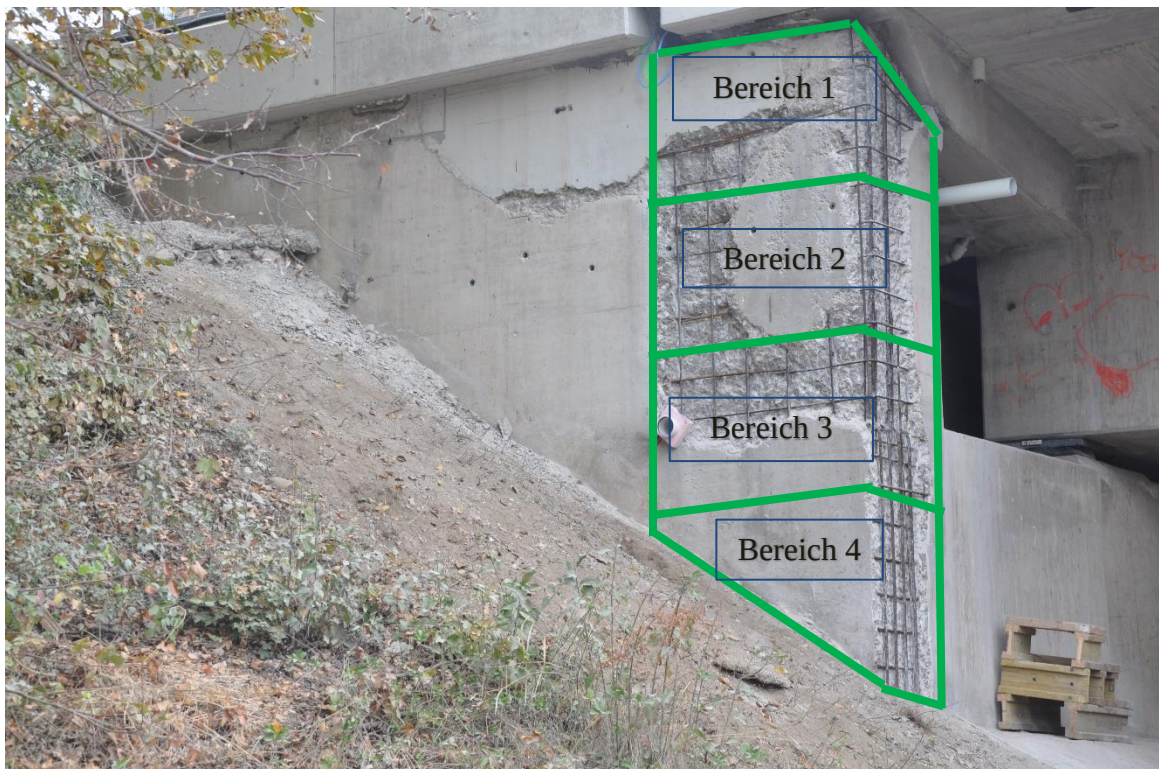
Abbildung 6.9: Vorbereiten der Sanierungsflächen durch Entfernen (Stemmen) des beschädigten Betons
