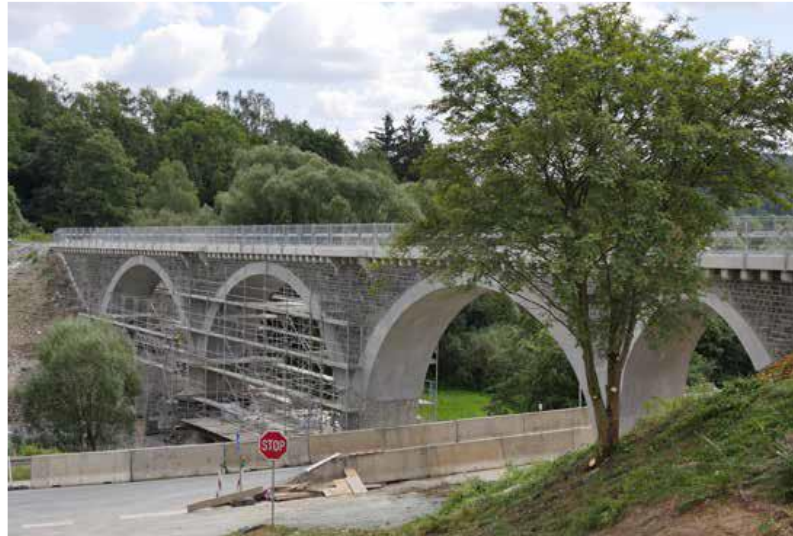
Abbildung 1.27: Instandsetzung der Bogenbrücke in Naila [65]
