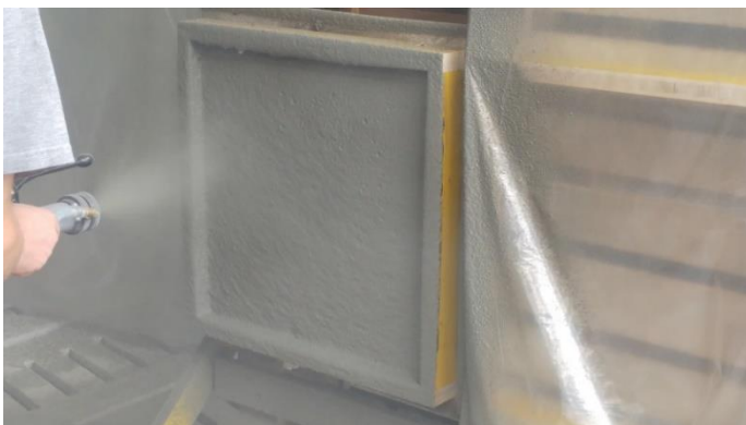
Abbildung 4.3: Aufsprühen der ersten Lage Feinbeton
