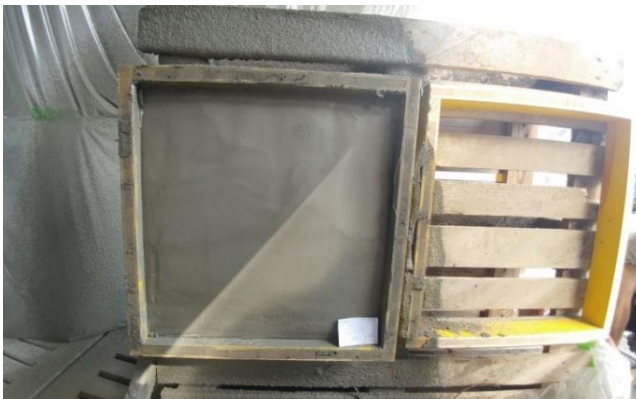
Abbildung 4.5: Nachgeglättete Feinbetonoberfläche der 2. Sprühlage
