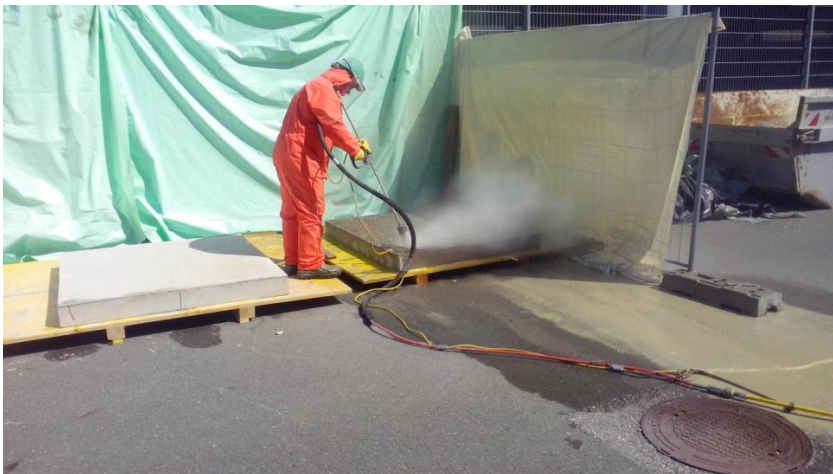
Abbildung 4.8: Oberflächenvorbehandlung mittels HDW-Strahlung (Fa. Junger GmbH.)
