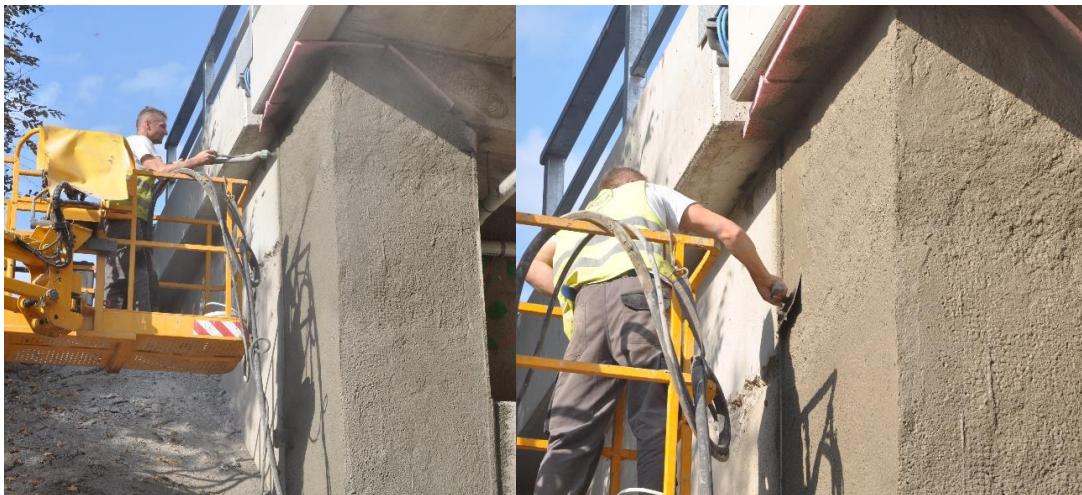
Abbildung 6.17: Sprühen einer dünnen Schicht Feinbeton (links) und Glätten von Oberflächen (rechts)
