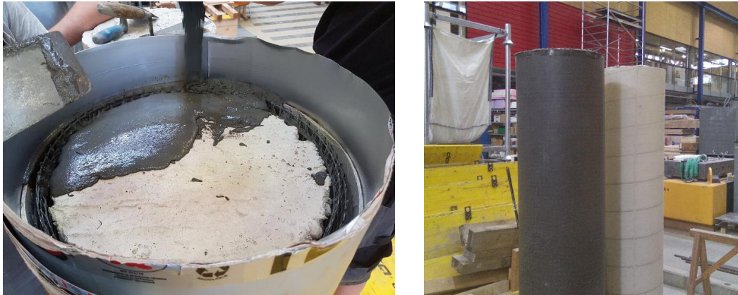
Abbildung 6.24: Herstellung der Stützenverstärkung
