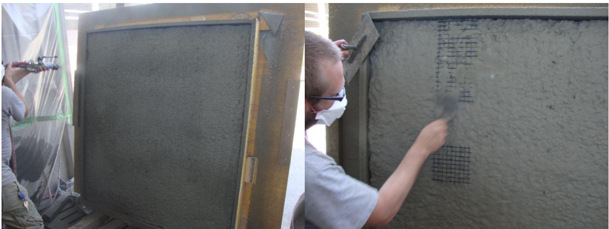
Abbildung 3.4: Aufsprühen des Feinbetons auf eine senkrecht stehende Betonplatte (links) und Einarbeitung des Carbondtextils in die erste Sprühbetonlage (rechts)
