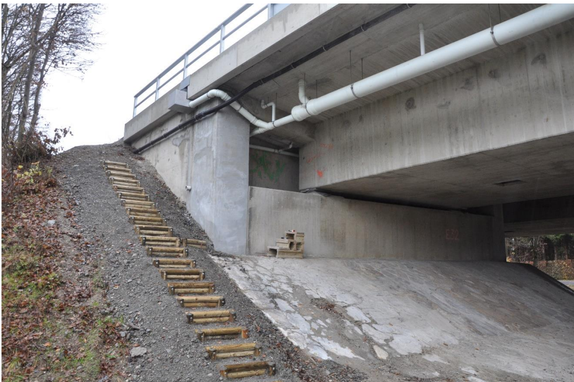
Abbildung 6.19: Sanierte Flächen nach 28 Tagen
