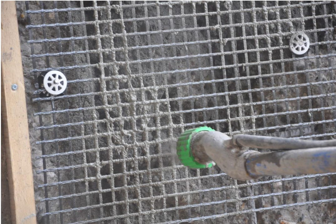
Abbildung 6.14: Foto- Sprühen des Feinbetons bzw. Füllen der Hohlstellen (etwa 8 cm hinter das Textilgelege) durch die die textile Bewehrung
