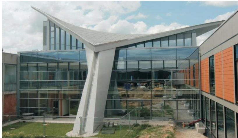
Abbildung 1.23: Hyparschale der Fachhochschule Schweinfurt nach der Sanierung
