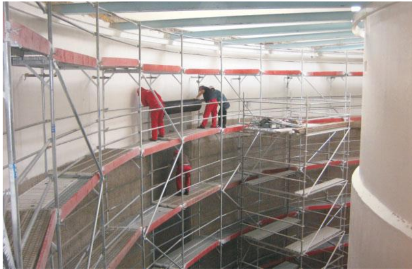
Abbildung 1.26: Einbringen des vorkonfektionierten Carbontextils
