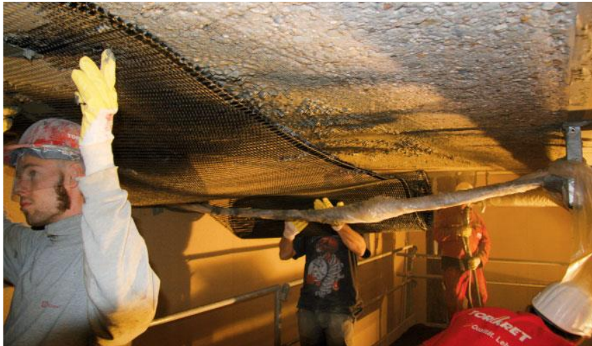
Abbildung 1.25: Applikation des Carbontextils an der Hallendecke
