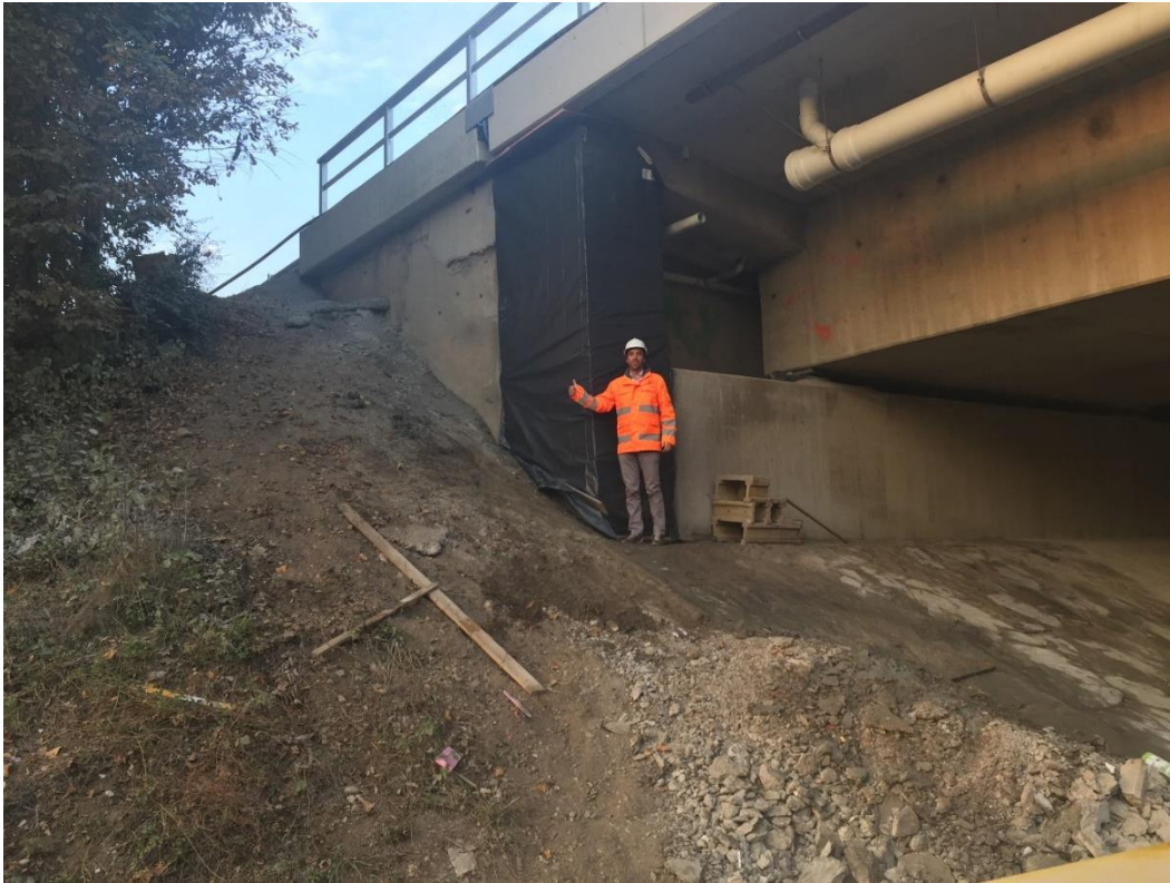
Abbildung 6.18: Nachbehandlung der sanierten Flächen durch Abdecken mit Folie für den Zeitraum von 3 Tagen.
