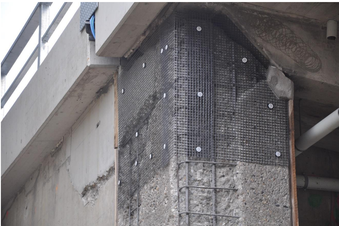
Abbildung 6.13: Anbringen des Textils mittels spezieller Abstandhalter DÜNA Fassadendübel mit Abstand (Typ M)
