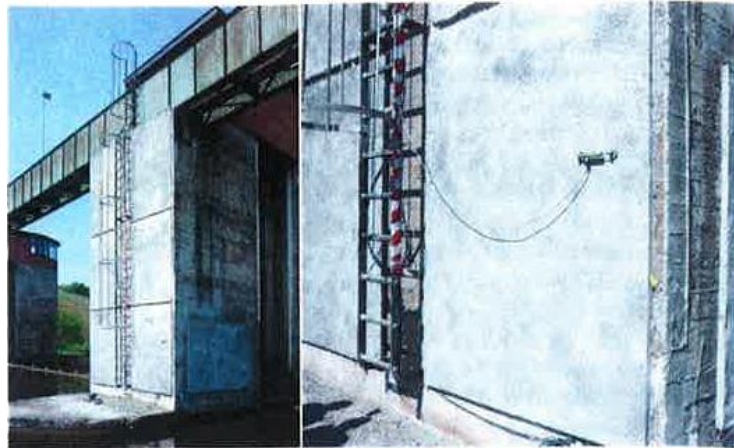
Abbildung 1.28: Durchgeführte Instandsetzung nach dem ersten Winter [67]
