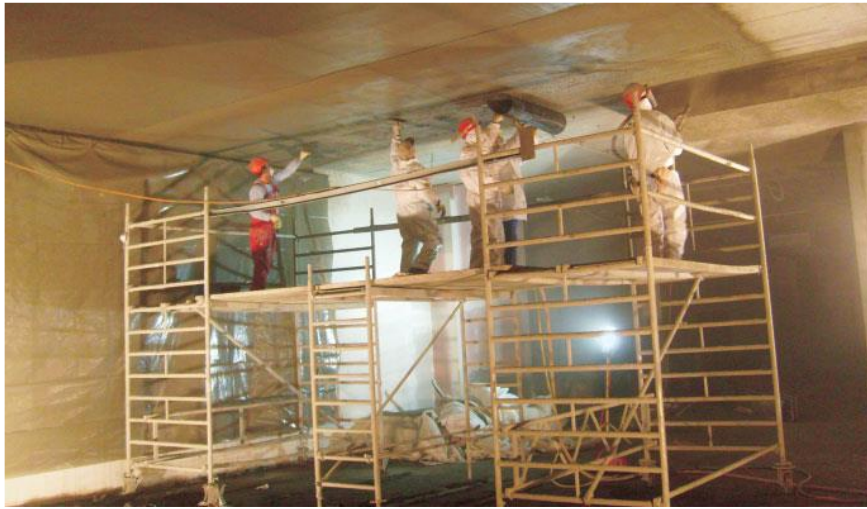
Abbildung 1.24: Parallele Ausführung von Feinbetonauftrag und Textilapplikation[59]
