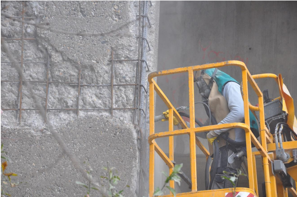
Abbildung 6.12: Entrosten der Bewehrung durch Sandstrahlen
