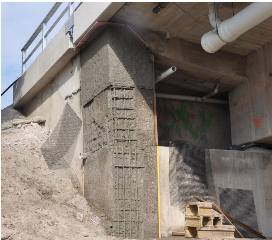
Abbildung 6.15: Füllen der Hohlstellen (2 Stunden Wartezeit nach Sprühen dieser Schicht)
