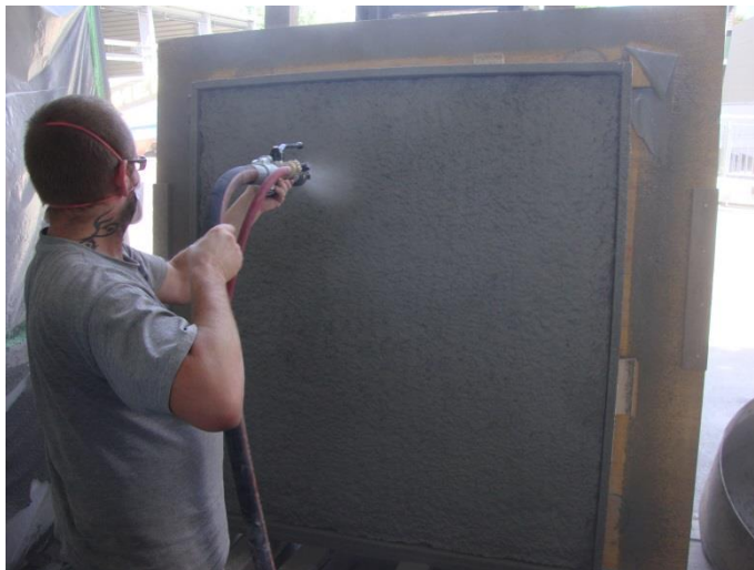
Abbildung 4.7: Aufsprühen der 2. Feinbetonlage mit I024
