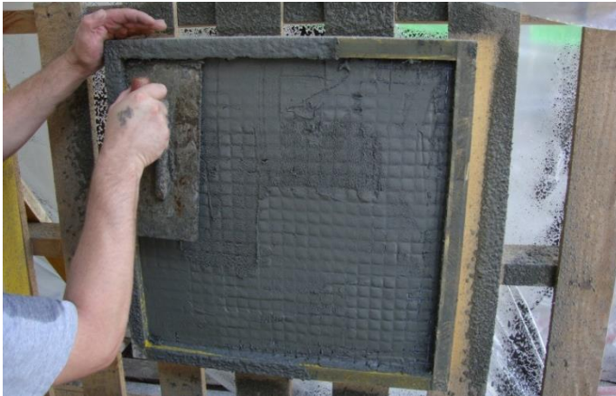
Abbildung 4.4: Einarbeiten des Carbontextils
