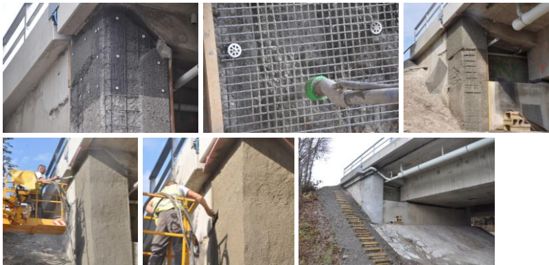
Abb. 2: Instandsetzung der geschädigten Flächen eines Brückenbauwerks mit Textilbeton
