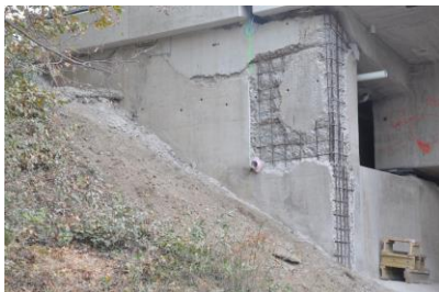
Abb 1: Geschädigte Flächen eines Brückenbauwerks nach Betonabtrag (links) und Prinzip einer Betoninstandsetzung mit Textilbeton (rechts)
