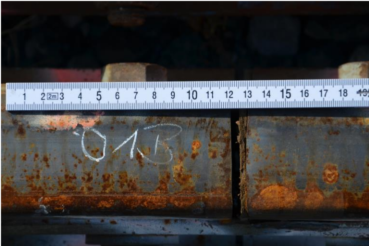
ABB 2. Defekter Isolierstoß – “auseinandergezogen”
