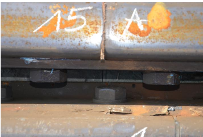
ABB 1. Defekter Isolierstoß – “zusammenwachsend”
