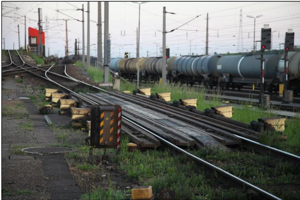
**Abbildung 14: Balkengleisbremse Wien Zentralverschiebebahnhof<sup>41</sup>**
