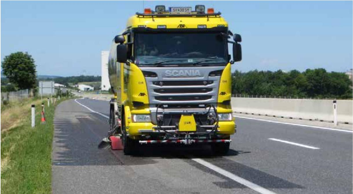
**Abb. 2-4: Reinigung der gefrästen Rumpelstreifen**
