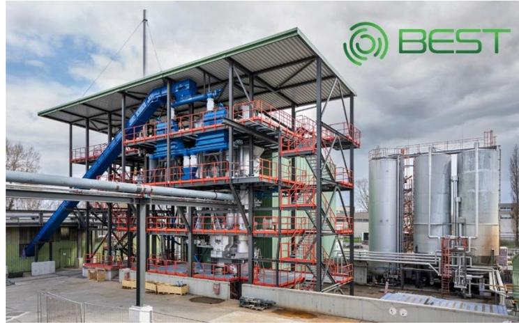
**Abbildung 17: Der 1 MW DFB Gaserzeuger der Syngas Plattform Wien**
